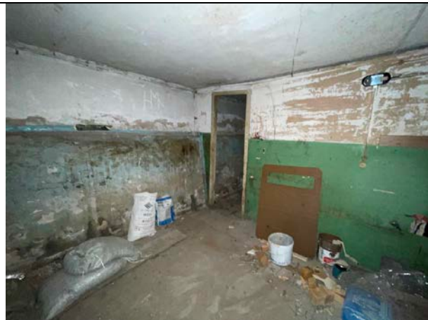
Фото 49. Типичное состояние Объекта оценки
