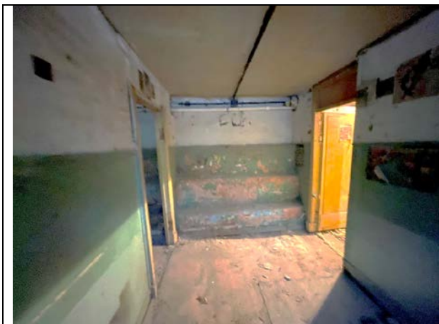
Фото 25. Типичное состояние Объекта оценки
