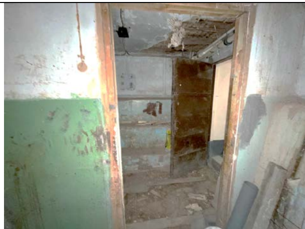
Фото 52. Типичное состояние Объекта оценки
