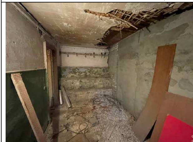
Фото 21. Типичное состояние Объекта оценки
