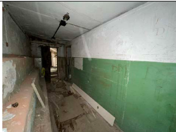
Фото 50. Типичное состояние Объекта оценки
