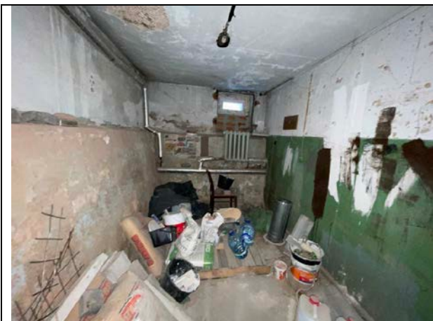
Фото 33. Типичное состояние Объекта оценки
