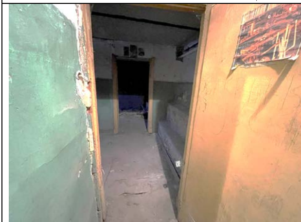
Фото 27. Типичное состояние Объекта оценки
