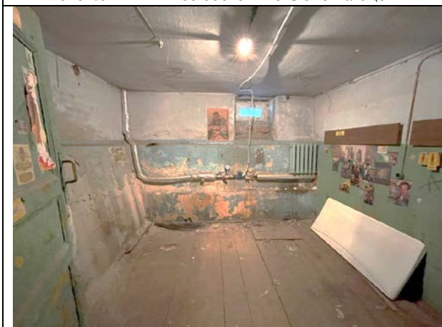
Фото 47. Типичное состояние Объекта оценки
