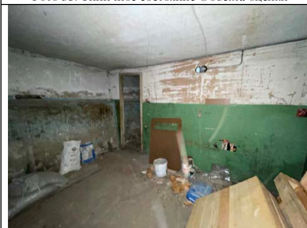
Фото 37. Типичное состояние Объекта оценки
