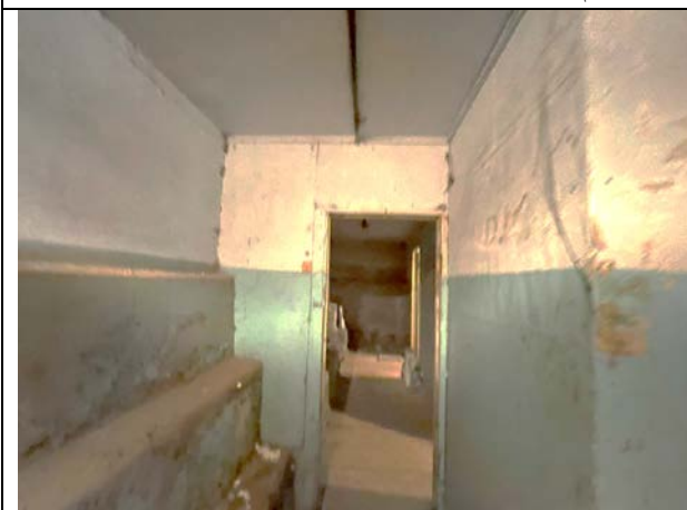
Фото 39. Типичное состояние Объекта оценки
