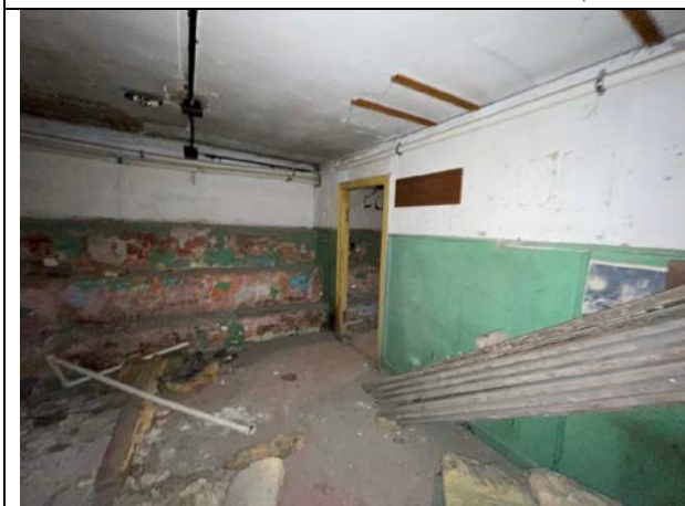
Фото 23. Типичное состояние Объекта оценки
