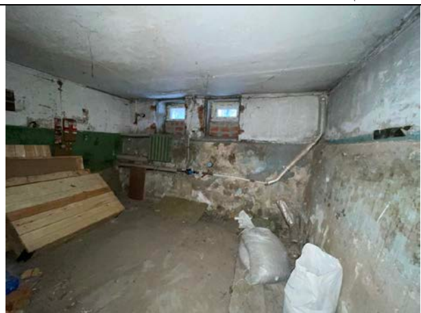
Фото 36. Типичное состояние Объекта оценки
