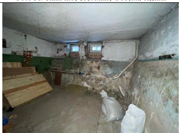
Фото 38. Типичное состояние Объекта оценки
