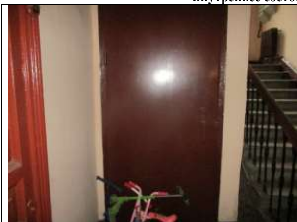
Фото 9. Вход Объекта оценки
