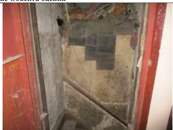
Фото 10. Внутреннее состояние Объекта оценки
