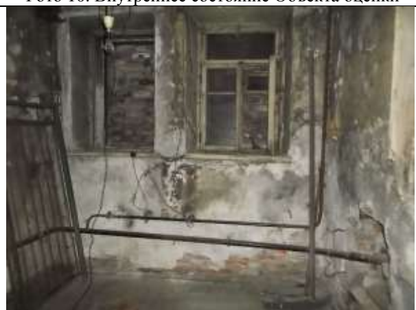
Фото 12. Внутреннее состояние Объекта оценки
