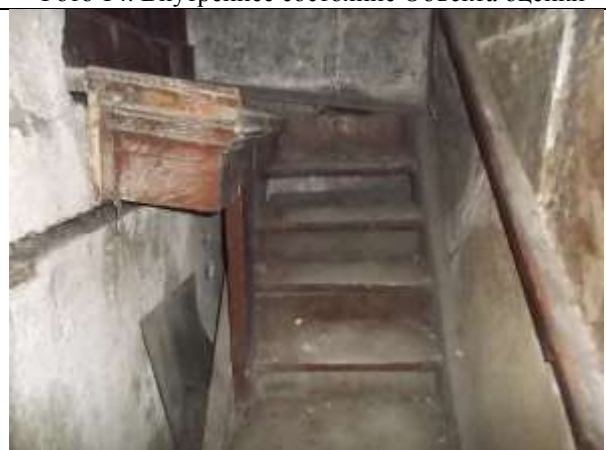
Фото 16. Внутреннее состояние Объекта оценки
