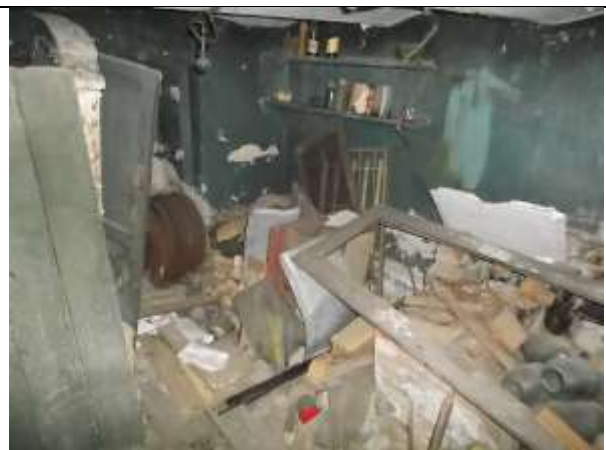
Фото 14. Внутреннее состояние Объекта оценки
