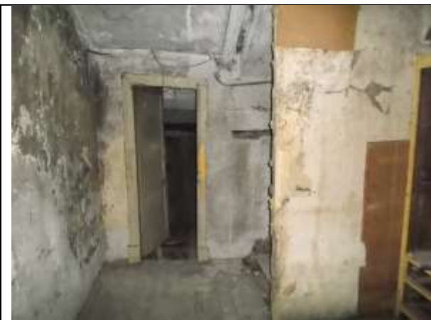
Фото 13. Внутреннее состояние Объекта оценки
