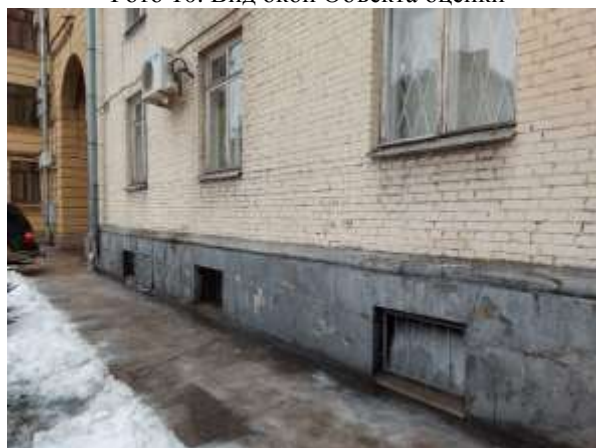
Фото 12. Вид окон Объекта оценки
