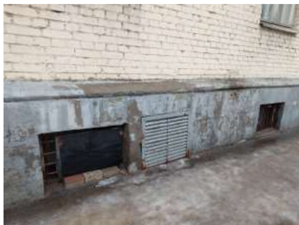
Фото 10. Вид окон Объекта оценки
