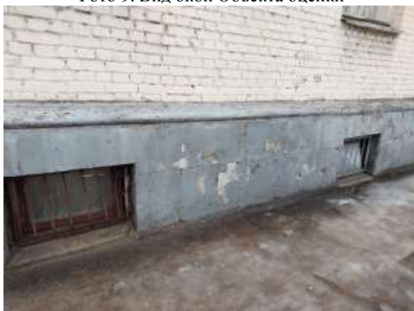
Фото 11. Вид окон Объекта оценки
