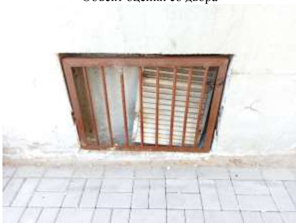
Фото 9. Вид окон Объекта оценки
