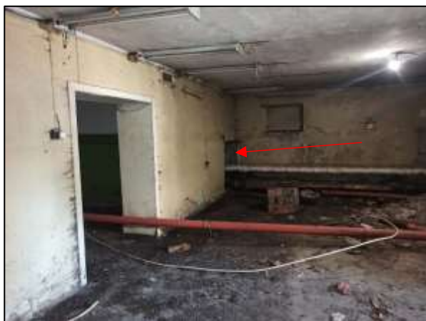
Фото 15. Вид доступа в тех. подполье лаз (из ч.п. 9 по плану) – не входит в оцениваемое помещение
