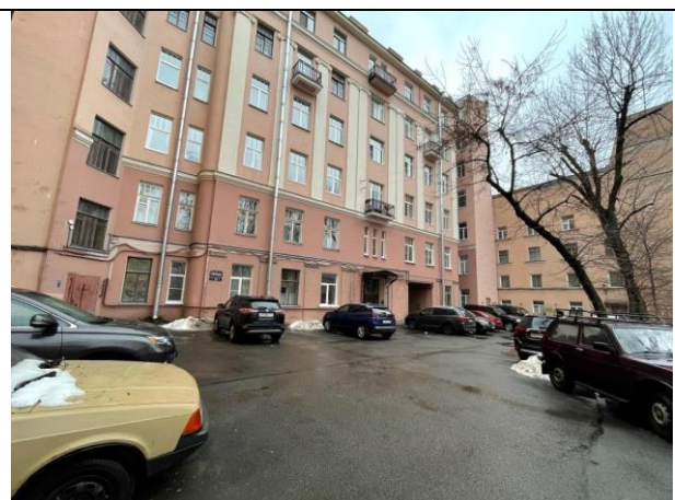
Фото 8. Вид здания расположения Объекта оценки
