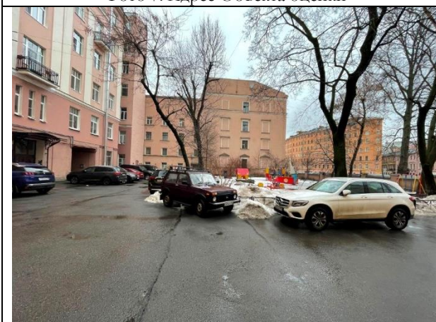
Фото 9. Внутри дворовая территория Объекта оценки
