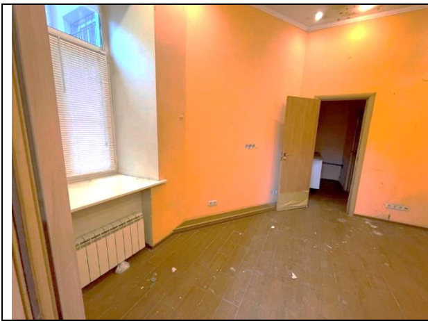
Фото 13. Типичное состояние Объекта оценки
