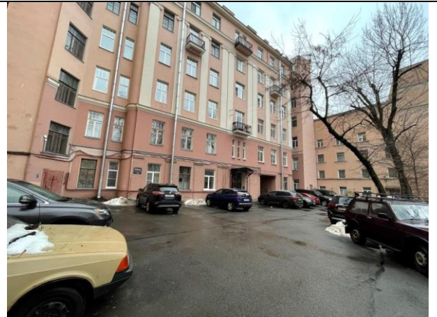
Фото 8. Вид здания расположения Объекта оценки
