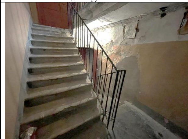
Фото 33. Лестничный проём Объекта оценки
