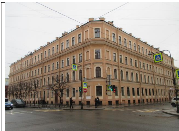
Фото № 1 – Здание, в котором расположен Объект оценки
