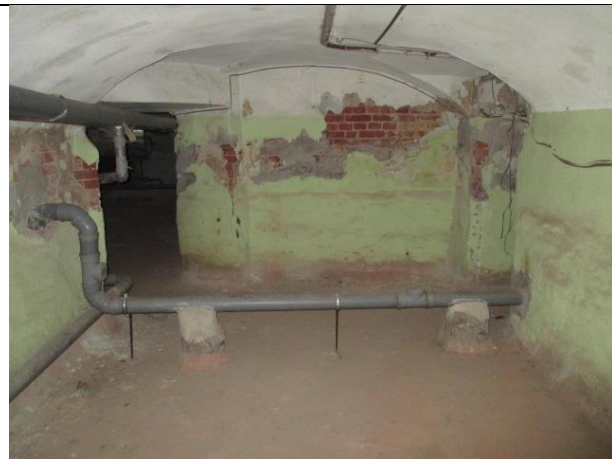
Фото № 8 - Внутренне состояние
