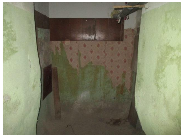
Фото № 16 - Внутреннее состояние
