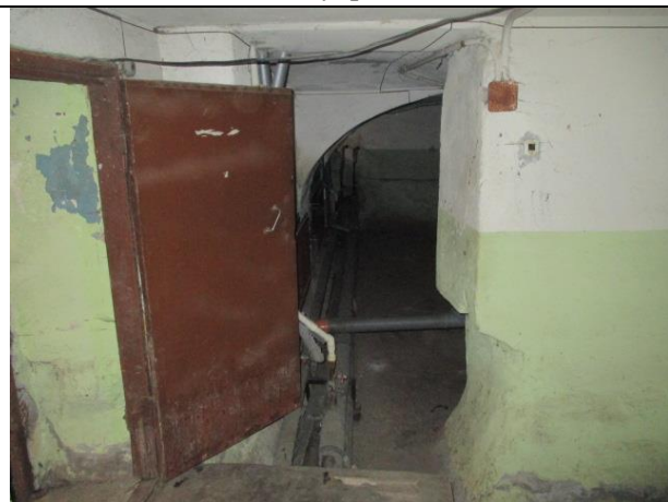
Фото № 12 - Внутреннее состояние
