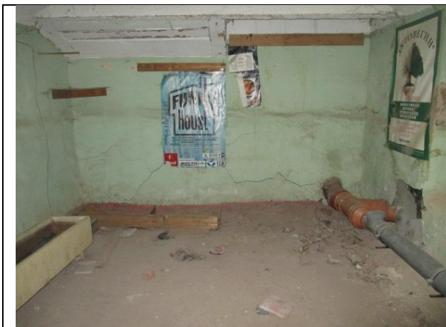
Фото № 15 - Внутреннее состояние
