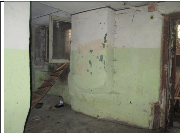
Фото № 7 - Внутренне состояние
