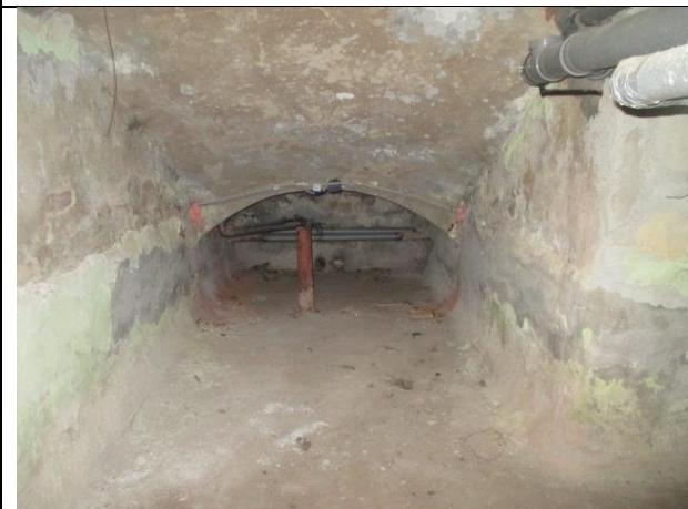
Фото № 9 - Внутренне состояние
