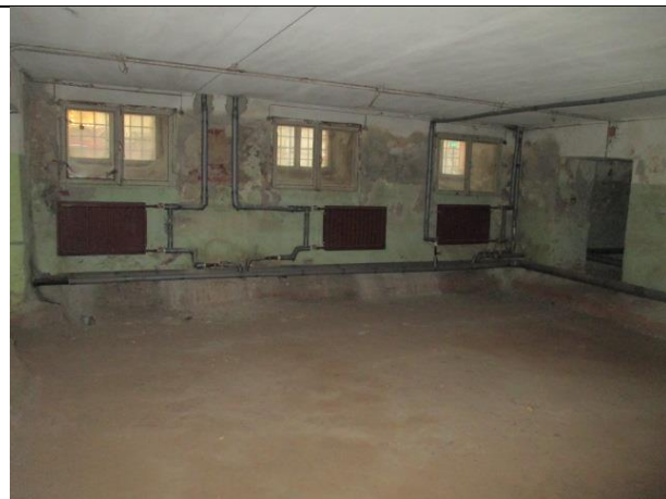
Фото № 10 - Внутренне состояние
