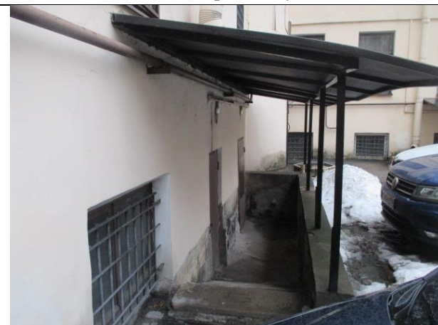
Фото № 5 – Вход в помещение
