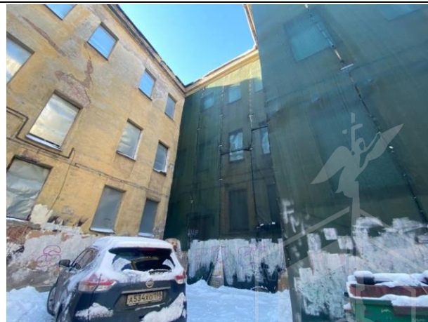
Фото № 8. Внешний вид здания
