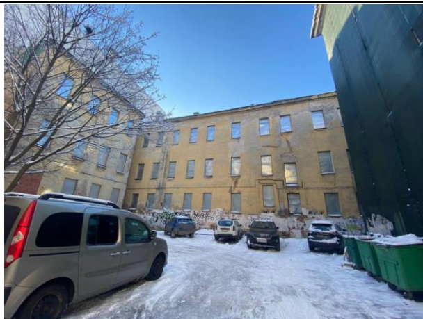
Фото № 7. Внешний вид земельного участка и здания
