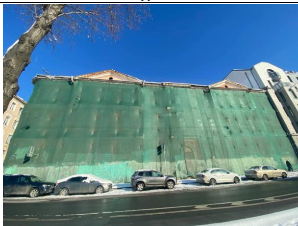
Фото № 5. Внешний вид здания
