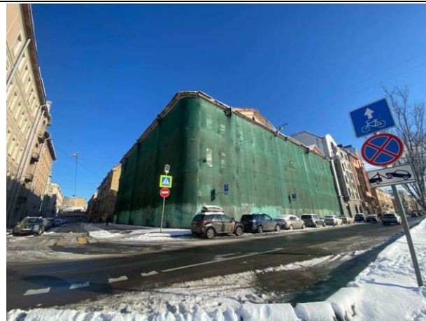
Фото № 2. Подъездные пути и окружение объекта
