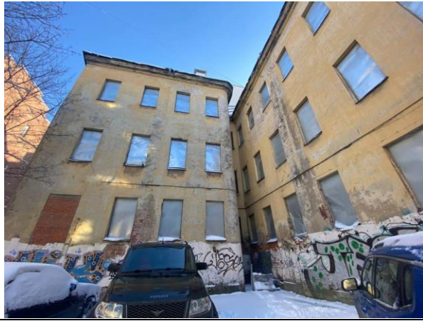
Фото № 9. Внешний вид здания
