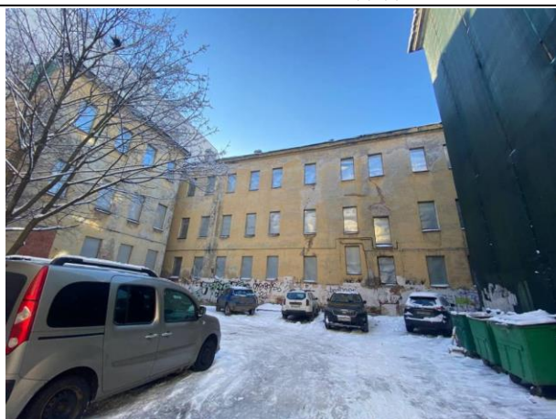
Фото № 7. Внешний вид земельного участка и здания
