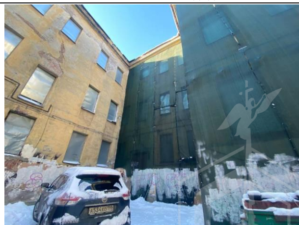
Фото № 8. Внешний вид здания
