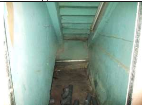
Фото 22. Внутреннее состояние Объекта оценки
