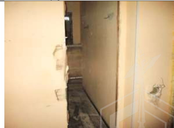
Фото 26. Внутреннее состояние Объекта оценки
