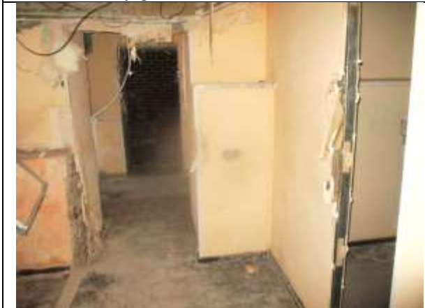
Фото 25. Внутреннее состояние Объекта оценки
