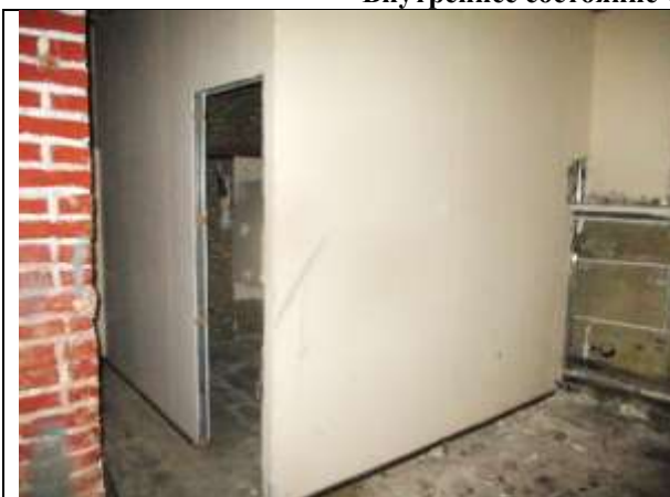
Фото 7. Внутреннее состояние Объекта оценки
