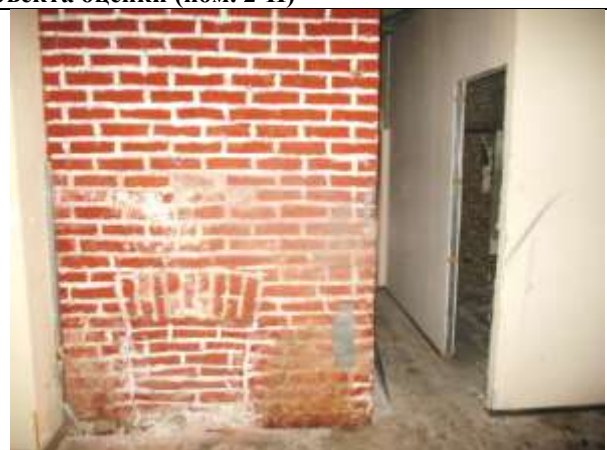
Фото 8. Внутреннее состояние Объекта оценки
