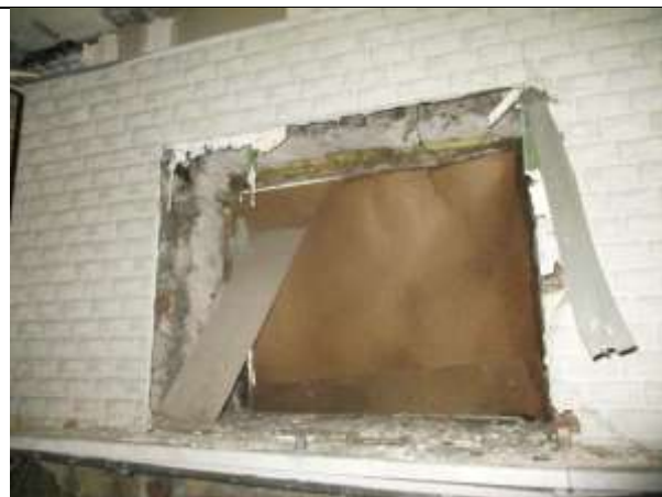
Фото 12. Внутреннее состояние Объекта оценки
