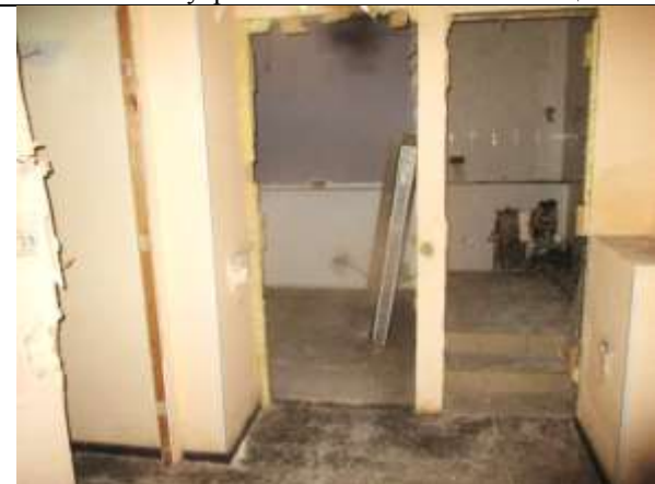
Фото 24. Внутреннее состояние Объекта оценки
