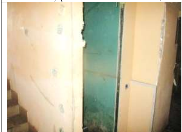
Фото 21. Внутреннее состояние Объекта оценки
