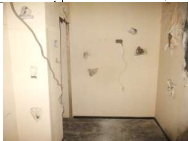
Фото 16. Внутреннее состояние Объекта оценки
