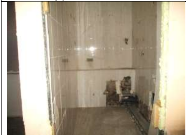
Фото 23. Внутреннее состояние Объекта оценки
