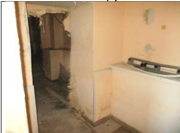
Фото 19. Внутреннее состояние Объекта оценки
