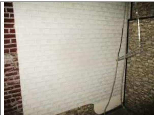
Фото 11. Внутреннее состояние Объекта оценки
