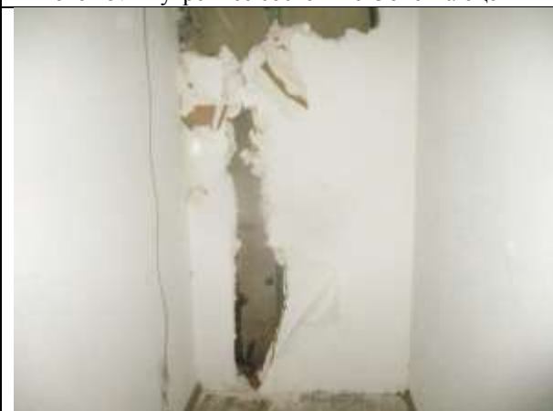
Фото 17. Внутреннее состояние Объекта оценки
