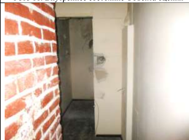
Фото 13. Внутреннее состояние Объекта оценки
