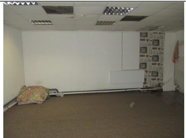
Фото № 11 – Внутреннее состояние помещения 11-Н
