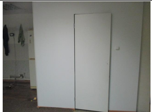
Фото № 13 – Внутреннее состояние помещения 11-Н
