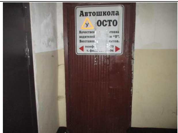
Фото № 8 – Вход в помещение 11-Н
