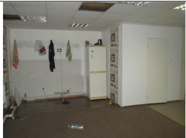
Фото № 12 – Внутреннее состояние помещения 11-Н
