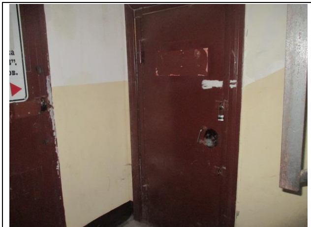
Фото № 15 – Вход в помещение 8-Н
