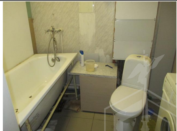
Фото № 14 – Внутреннее состояние помещения 11-Н
