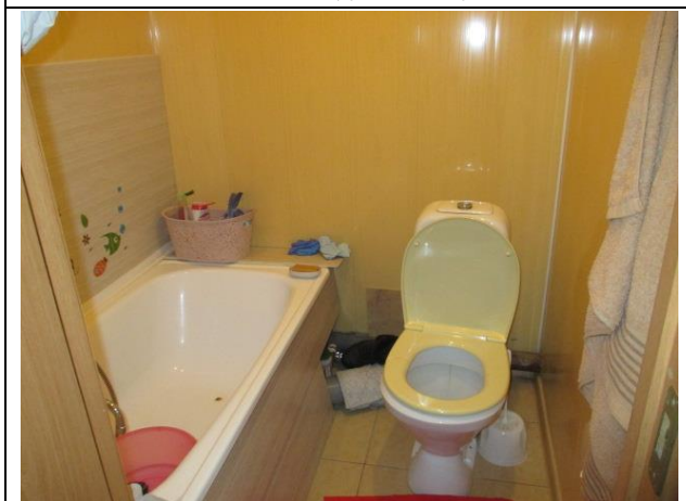
Фото № 17 – Внутреннее состояние помещения 8-Н
