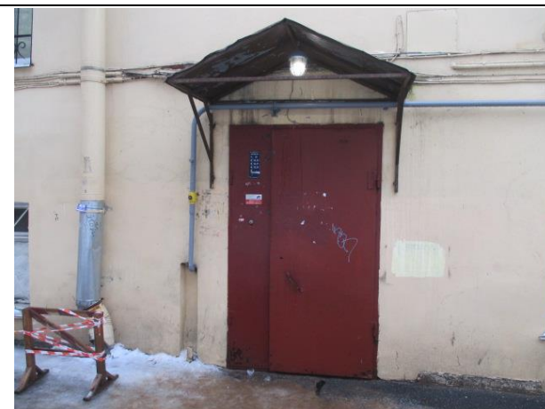
Фото № 4 – Вход в помещение со двора
