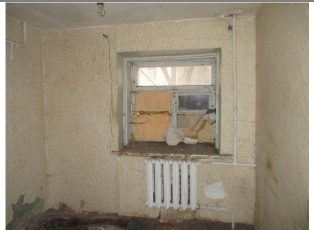
Фото № 10 – Внутреннее состояние помещения
