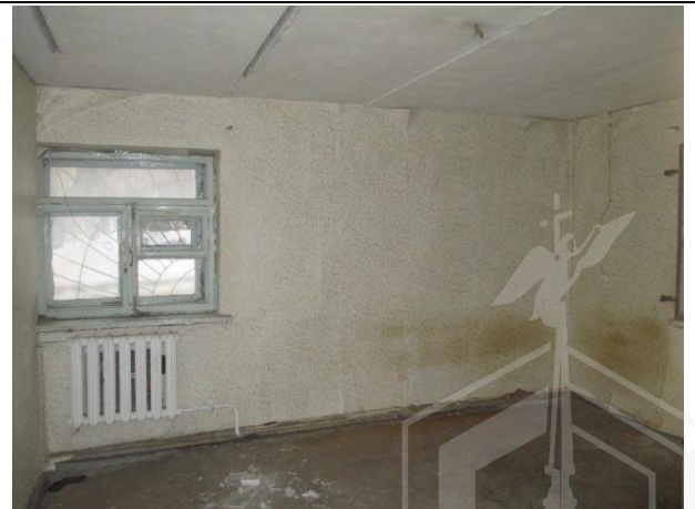
Фото № 14 – Внутреннее состояние помещения
