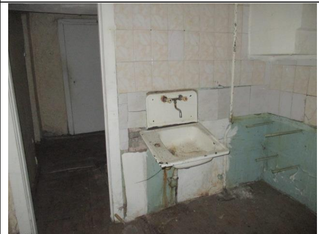
Фото № 11 – Внутреннее состояние помещения
