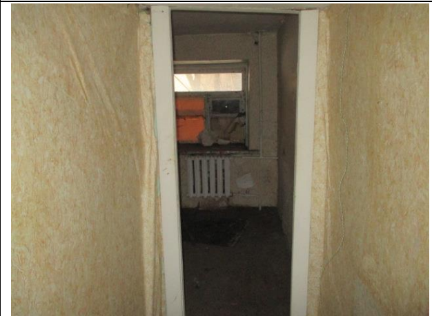
Фото № 9 – Внутреннее состояние помещения
