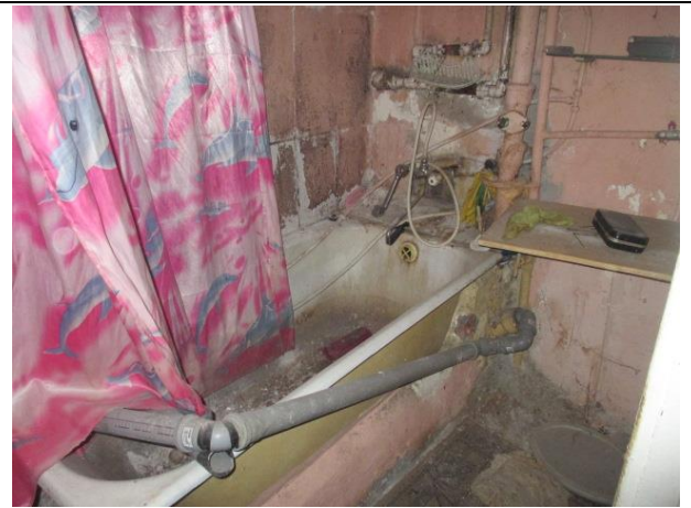
Фото № 8 – Внутреннее состояние помещения
