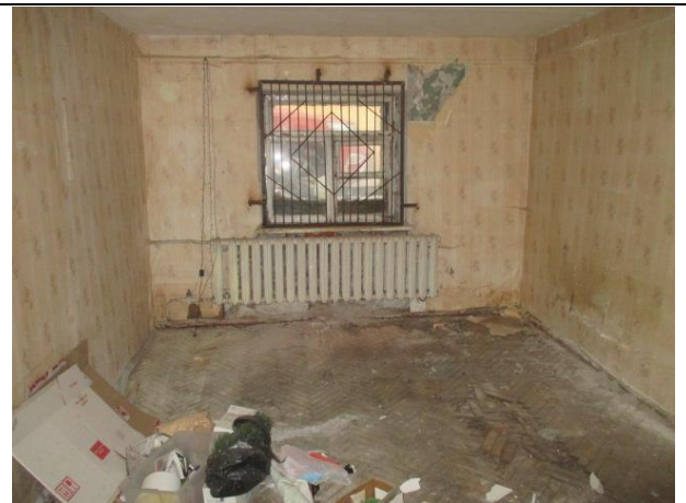
Фото № 12 – Внутреннее состояние помещения
