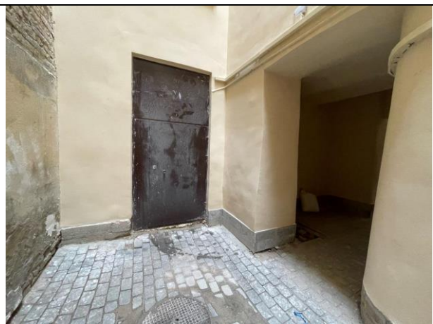
Фото 18. Проход через арку к Объекту оценки
