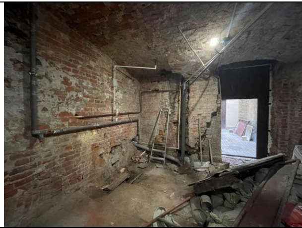
Фото 24. Типичное состояние Объекта оценки
