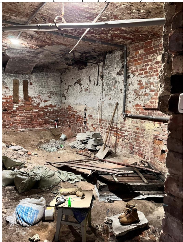
Фото 20. Типичное состояние Объекта оценки
