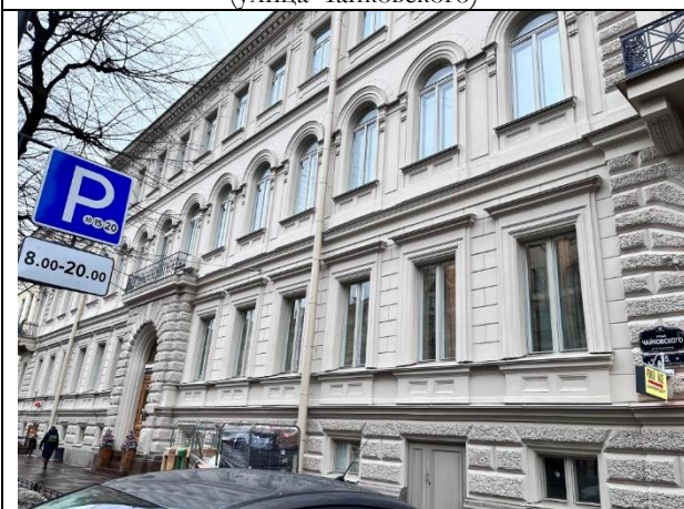
Фото 13. Вид здания расположения Объекта оценки
