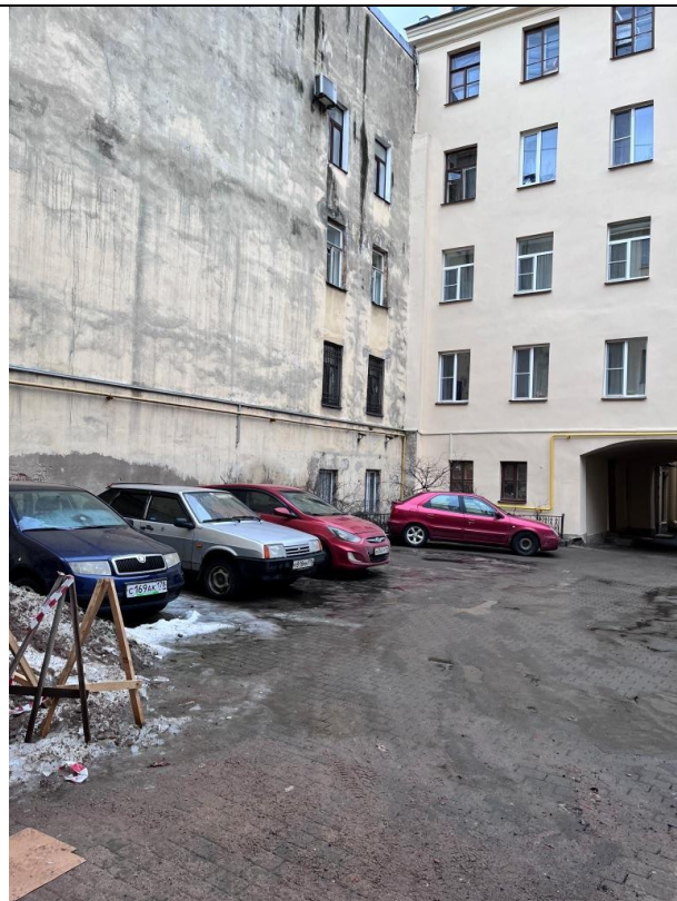
Фото 25. Внутри дворовая территория Объекта оценки
