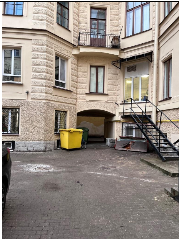
Фото 26. Внутри дворовая территория Объекта оценки
