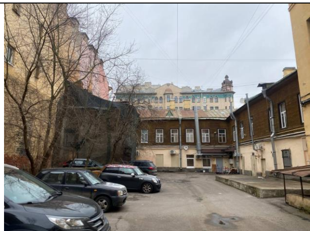
Фото № 2 – Здание, в котором расположен объект оценки
