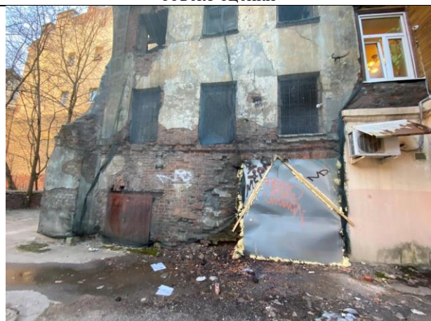
Фото № 4 – Здание, в котором расположен объект оценки
