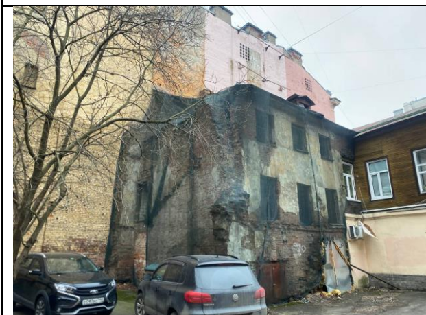
Фото № 5 – Здание, в котором расположен объект оценки
