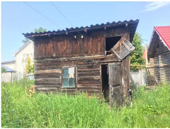
Фото 15. Вид на оцениваемый земельный участок и постройку (не входит в состав Объекта оценки), расположенную на нем.
