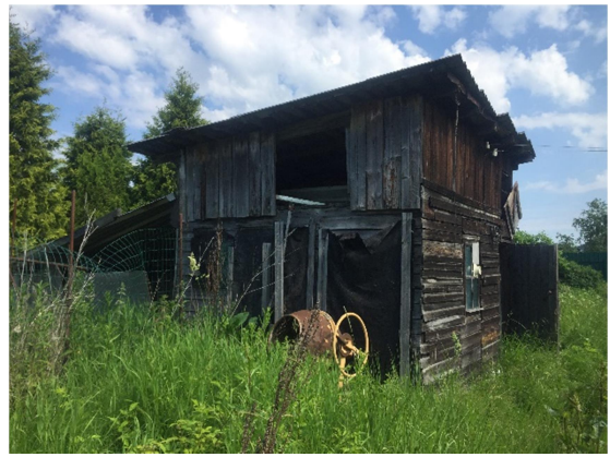
Фото 16. Вид на оцениваемый земельный участок и постройку (не входит в состав Объекта оценки), расположенную на нем.
