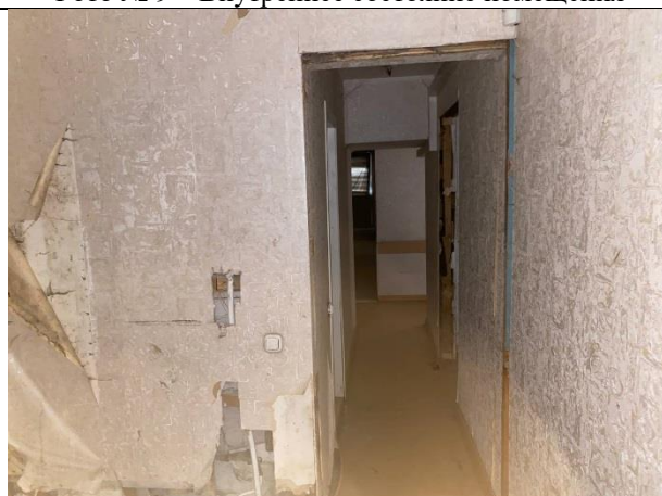
Фото № 11 – Внутреннее состояние помещения
