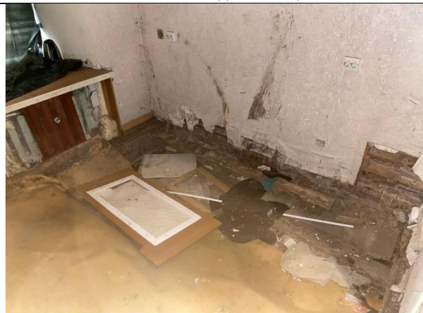
Фото № 8 – Внутреннее состояние помещения
