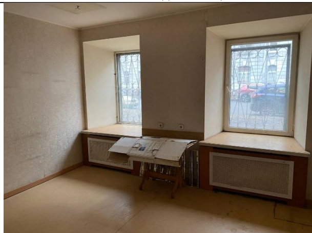
Фото № 7 – Внутреннее состояние помещения
