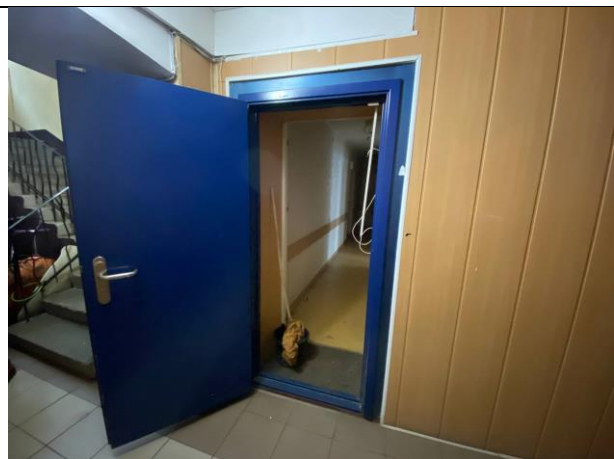
Фото № 6 – Вход в помещение
