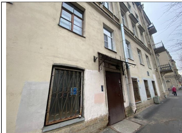
Фото № 5 – Вход в помещение
