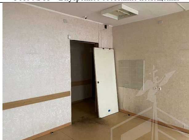
Фото № 12 – Внутреннее состояние помещения
