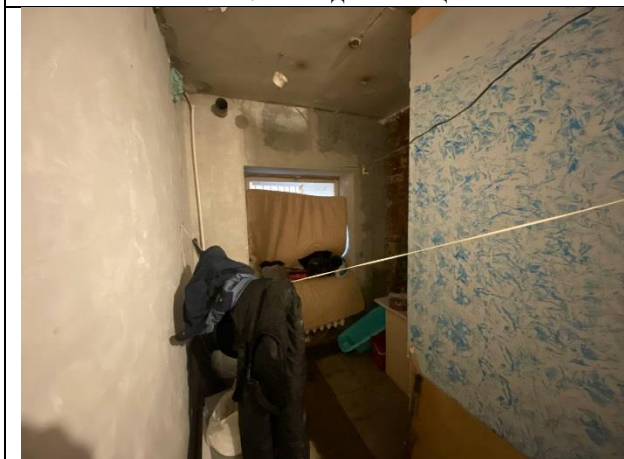
Фото № 9 – Внутреннее состояние помещения
