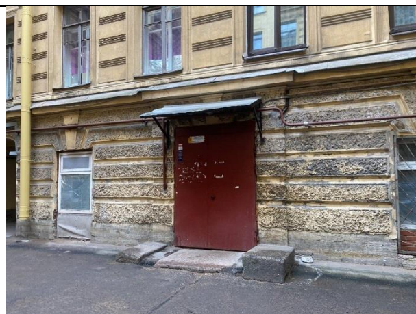
Фото № 4 – Общий вход в помещение
