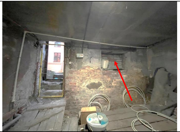
Фото 20. Входная и оконная группа Объекта оценки
