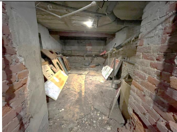
Фото 21. Типичное состояние Объекта оценки
