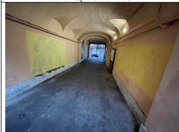
Фото 15. Проход через арку к Объекту оценки
