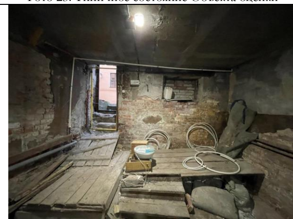
Фото 25. Типичное состояние Объекта оценки
