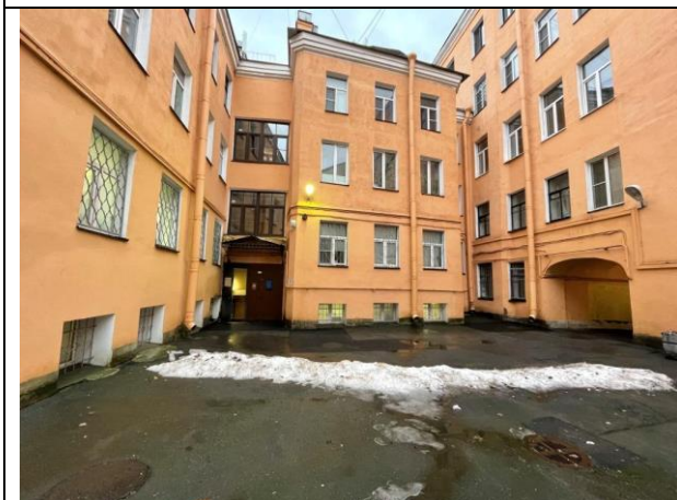
Фото 17. Внутри дворовая территория Объекта оценки
