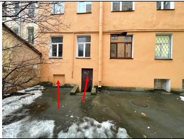
Фото 19. Входная и оконная группа Объекта оценки
