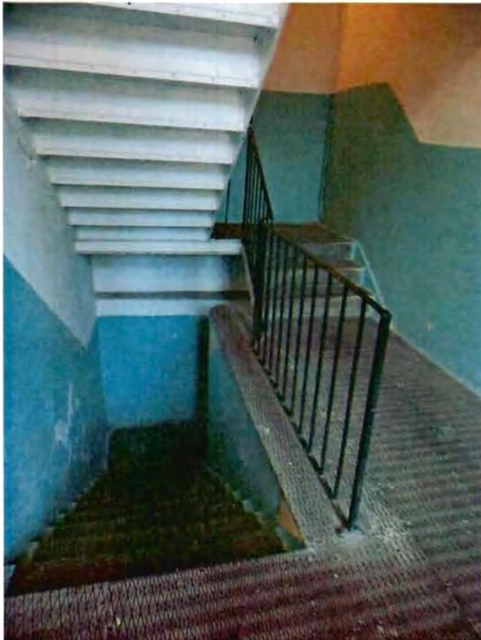
12. Лестница Л-3 (восточный корпус)
