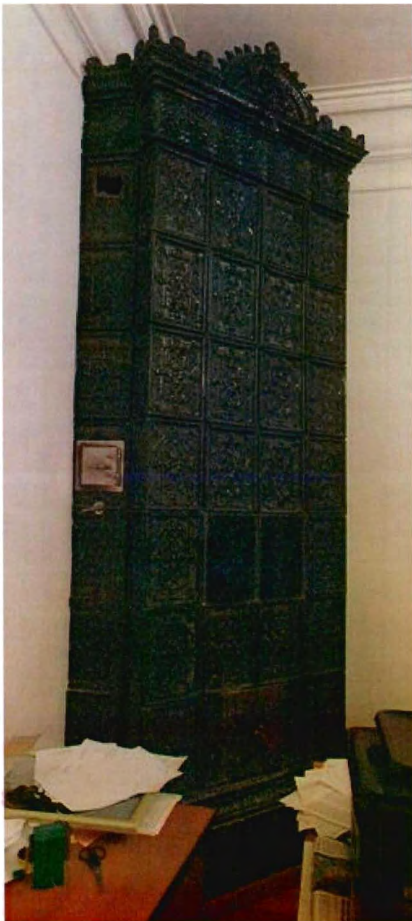
13. Печь, расположенная в помещении 1 этажа
