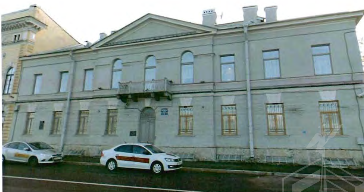
2. Фасад по Английской набережной
