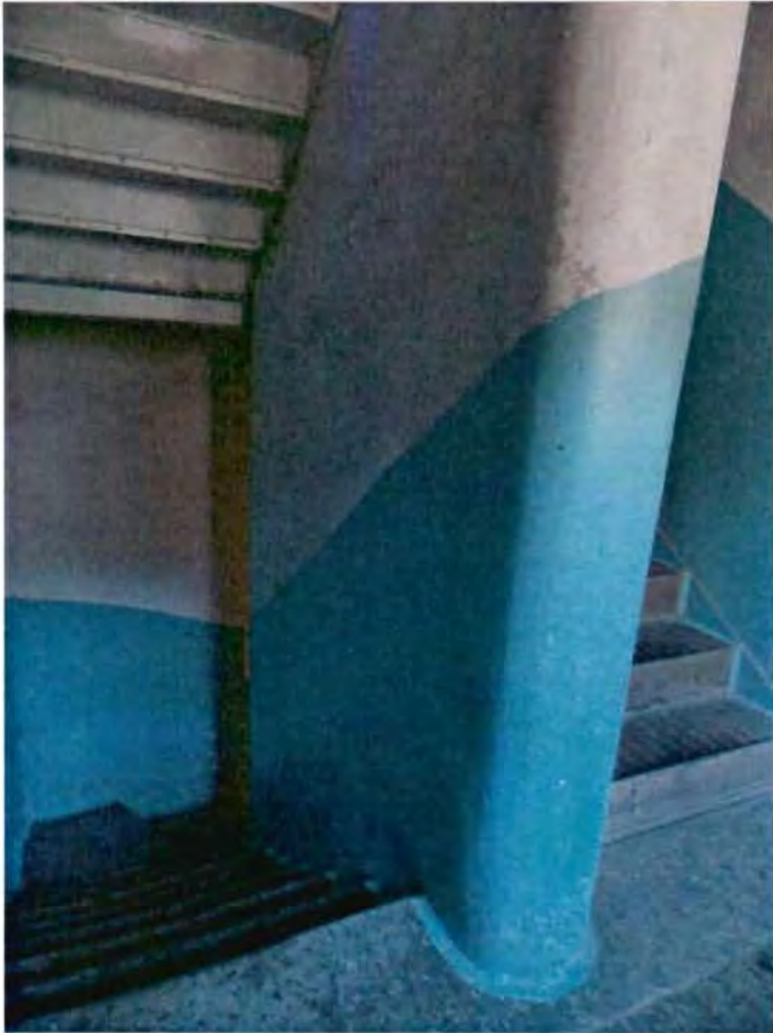
11. Лестница Л-3 (восточный корпус)
