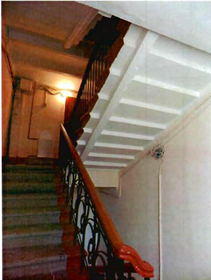
10. Лестница Л-2 (западный корпус)
