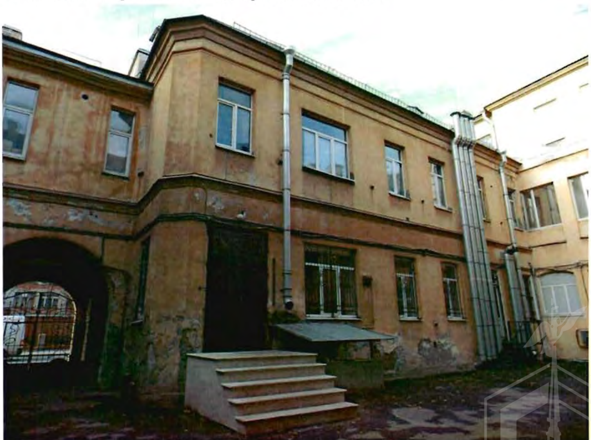
4. Западный дворовый фасад
