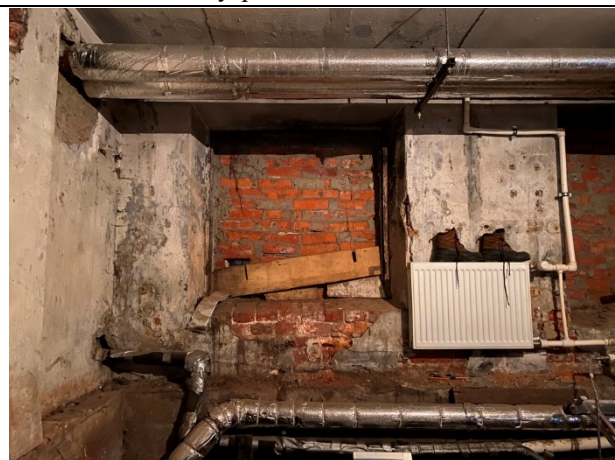
Фото № 12. Внутреннее состояние помещения
