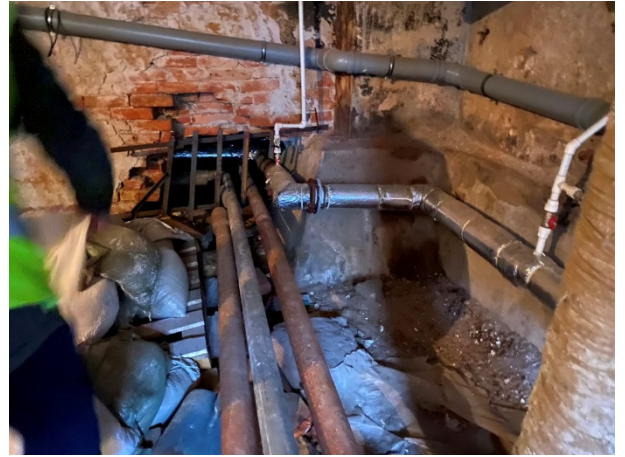
Фото № 18. Внутреннее состояние помещения
