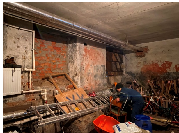
Фото № 10. Внутреннее состояние помещения
