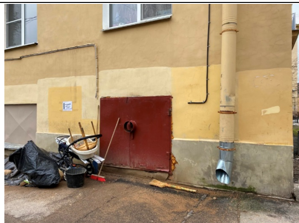
Фото № 8. Вход в помещение со двора
