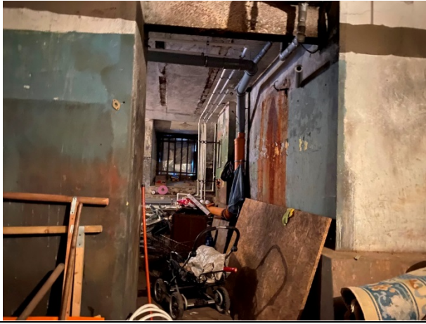
Фото № 15. Внутреннее состояние помещения
