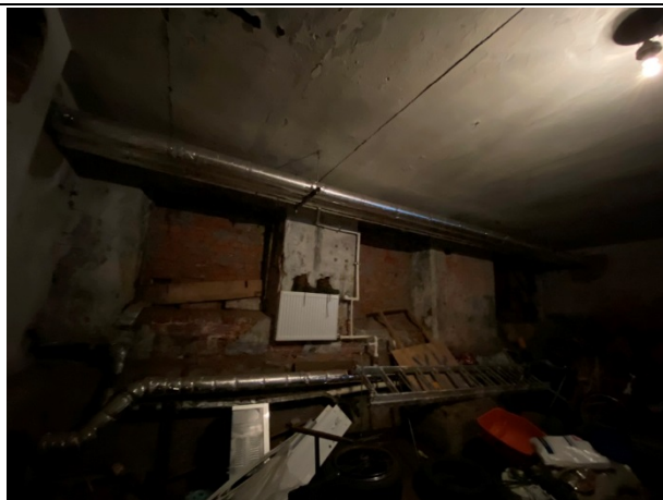
Фото № 9. Внутреннее состояние помещения
