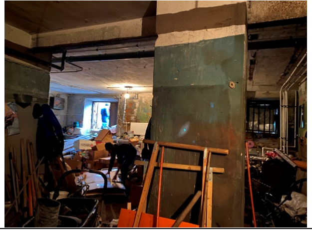
Фото № 16. Внутреннее состояние помещения
