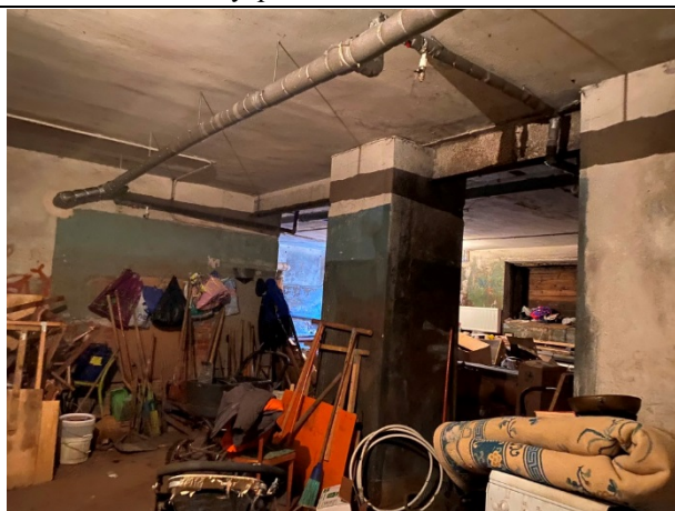
Фото № 11. Внутреннее состояние помещения
