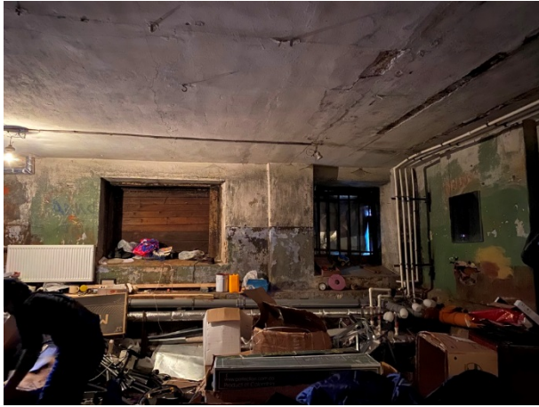
Фото № 17. Внутреннее состояние помещения
