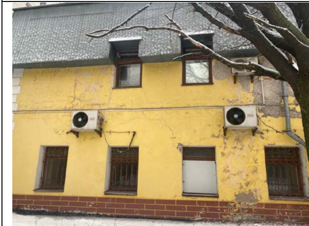
Фото № 13. Внешний вид здания
