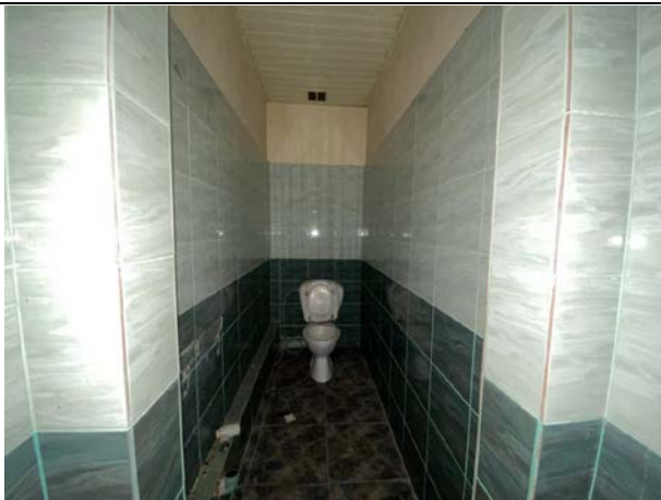
Фото № 37. Внутреннее состояние здания
