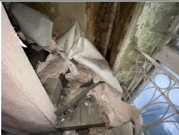
Фото № 31. Внутреннее состояние здания
