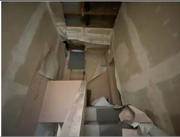
Фото № 33. Внутреннее состояние здания
