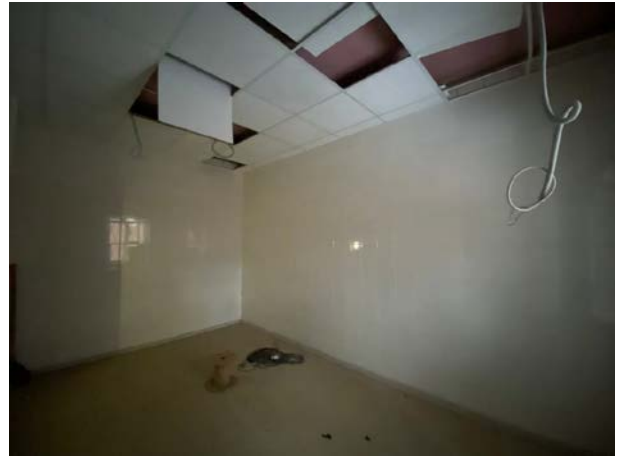
Фото № 20. Внутреннее состояние здания
