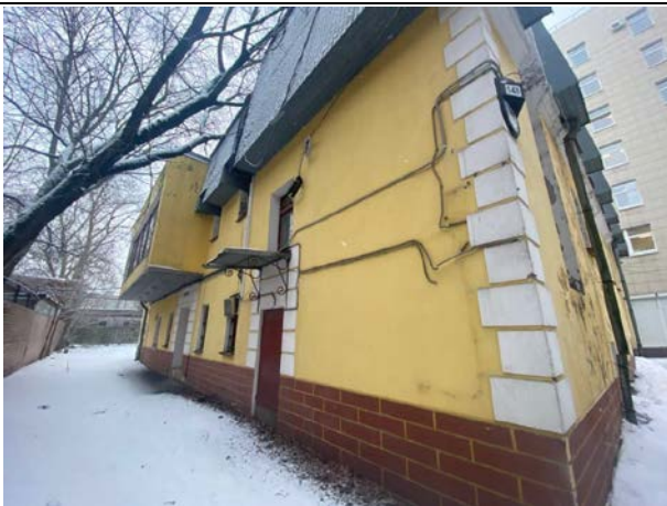
Фото № 7. Внешний вид земельного участка и здания
