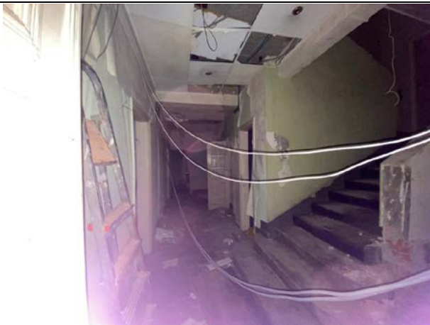
Фото № 21. Внутреннее состояние здания
