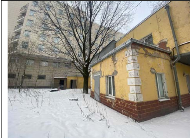
Фото № 11. Внешний вид земельного участка и здания
