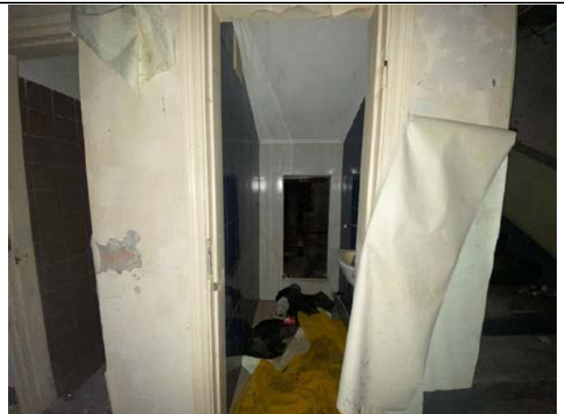
Фото № 22. Внутреннее состояние здания
