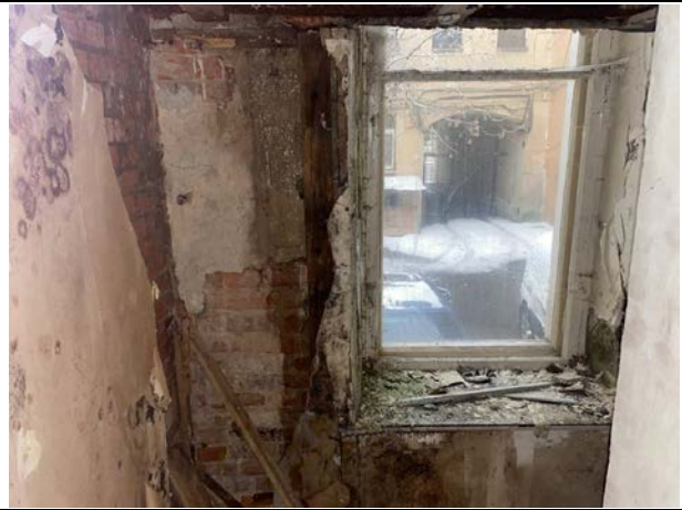
Фото № 34. Внутреннее состояние здания
