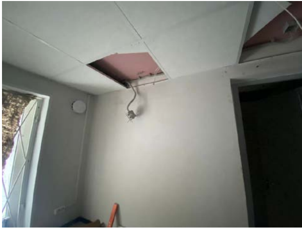
Фото № 19. Внутреннее состояние здания
