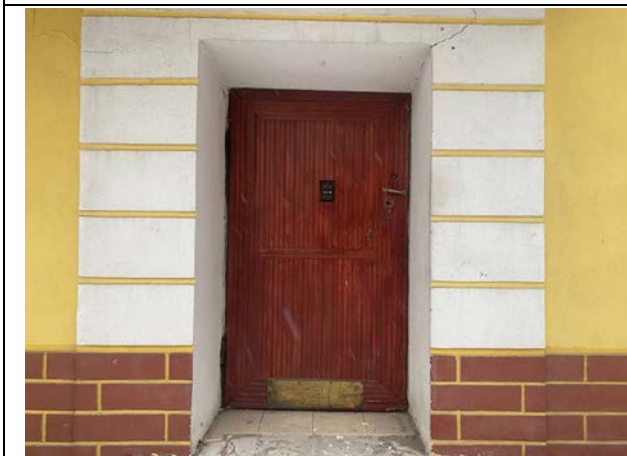
Фото № 15. Вход в здание
