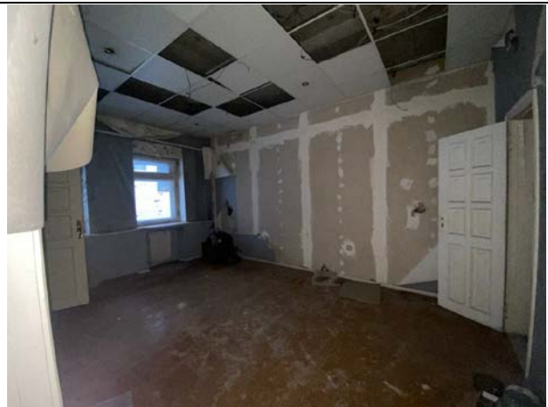
Фото № 38. Внутреннее состояние здания
