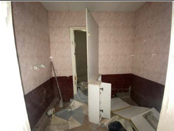
Фото № 39. Внутреннее состояние здания
