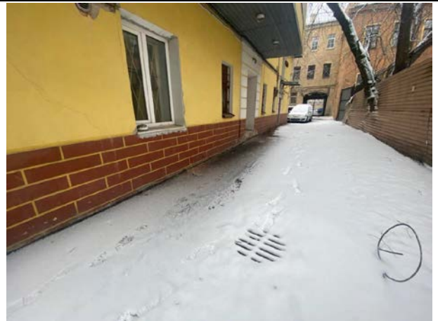
Фото № 12. Внешний вид земельного участка и здания
