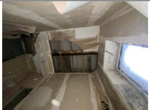
Фото № 30. Внутреннее состояние здания
