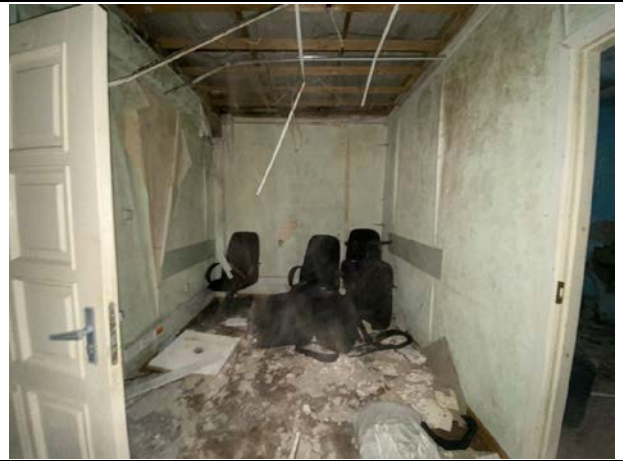
Фото № 26. Внутреннее состояние здания
