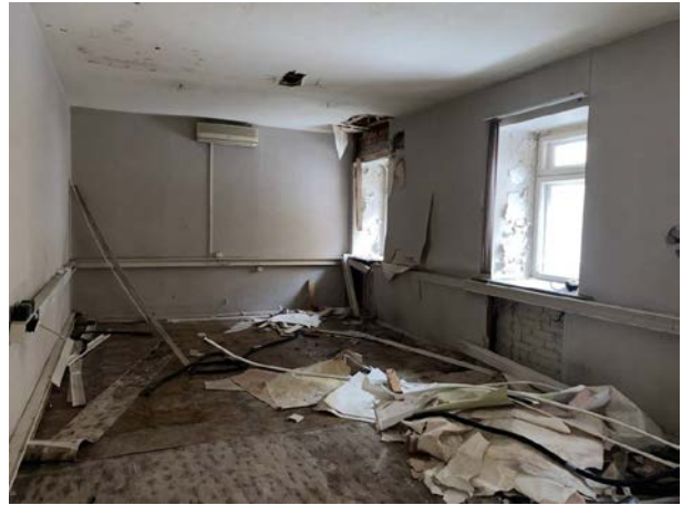
Фото № 36. Внутреннее состояние здания
