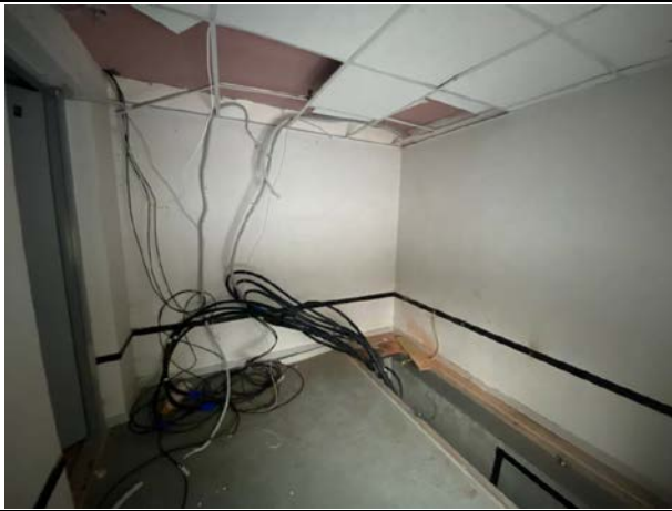
Фото № 17. Внутреннее состояние здания
