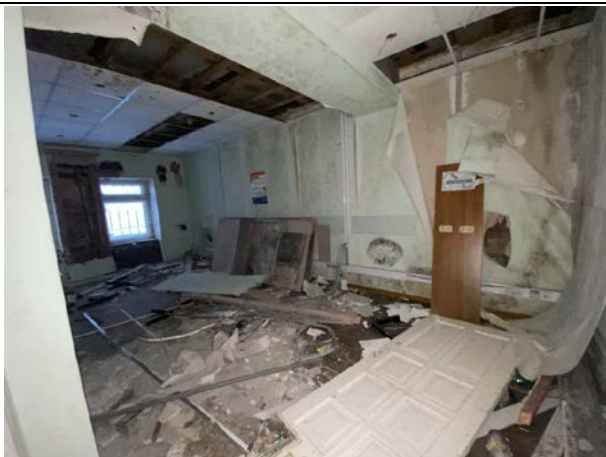
Фото № 23. Внутреннее состояние здания
