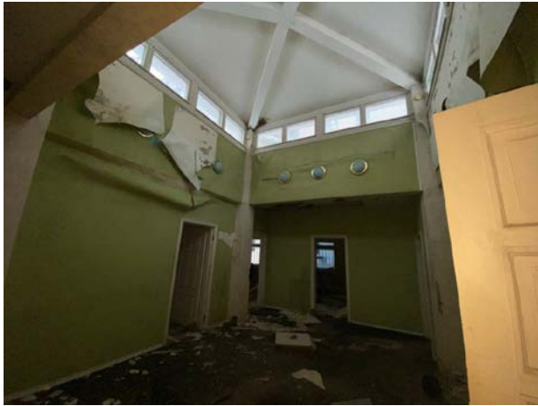
Фото № 35. Внутреннее состояние здания
