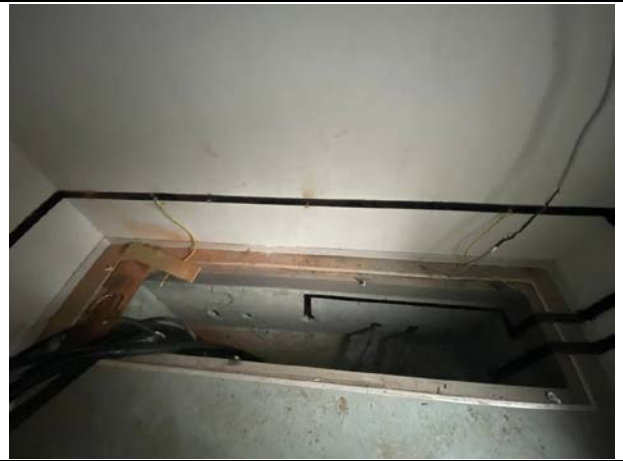
Фото № 18. Внутреннее состояние здания
