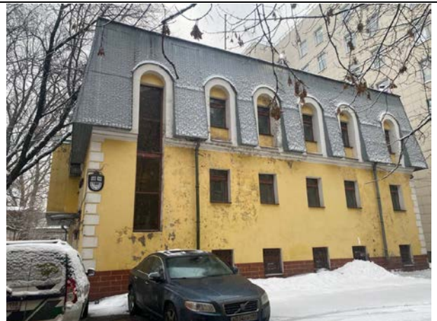
Фото № 14. Внешний вид здания
