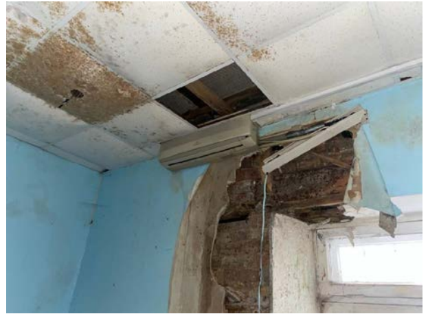
Фото № 28. Внутреннее состояние здания
