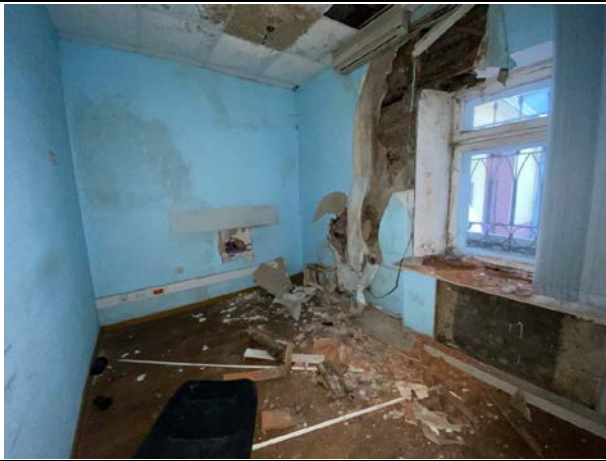
Фото № 25. Внутреннее состояние здания
