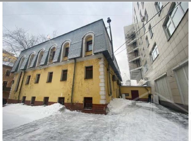
Фото № 8. Внешний вид земельного участка и здания
