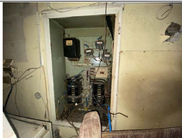
Фото № 42. Внутреннее состояние здания
