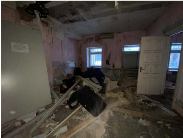
Фото № 27. Внутреннее состояние здания
