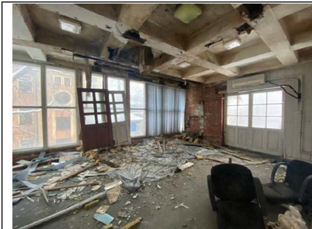
Фото № 41. Внутреннее состояние здания
