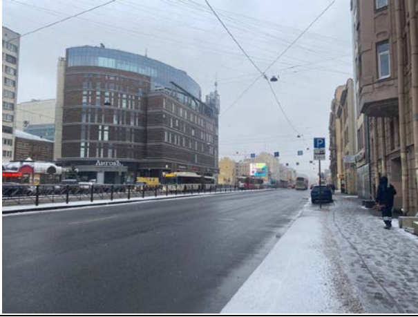
Фото № 1. Подъездные пути и окружение объекта
