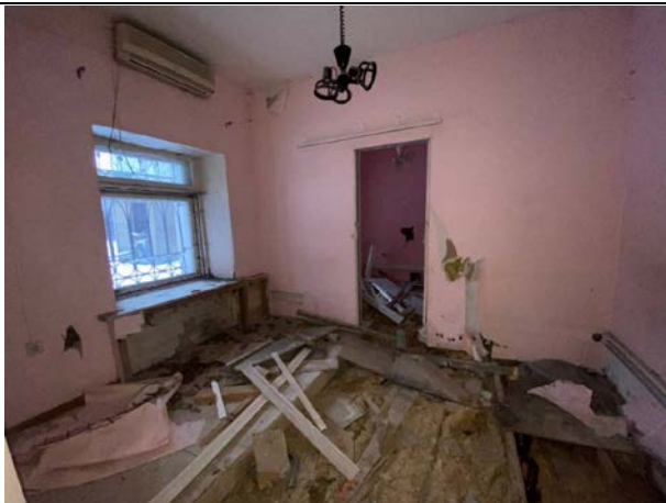
Фото № 29. Внутреннее состояние здания
