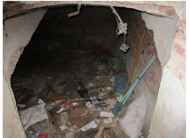
Фото 6 Вид помещения 4-Н
