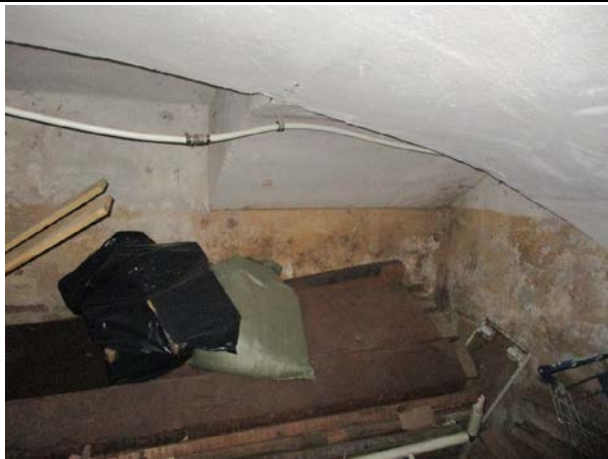
Фото 7 Вид помещения 4-Н
