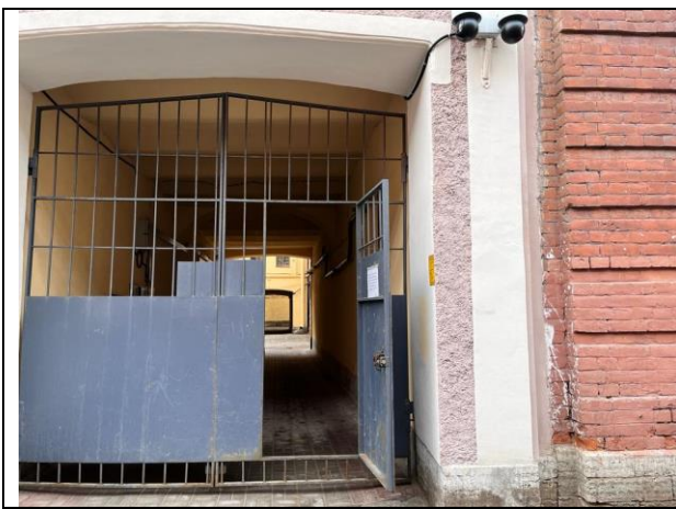
Фото 13. Проход через арку к Объекту оценки
