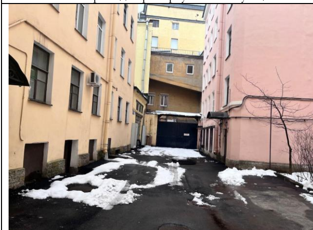
Фото 15. Внутривордовая территория Объекта оценки
