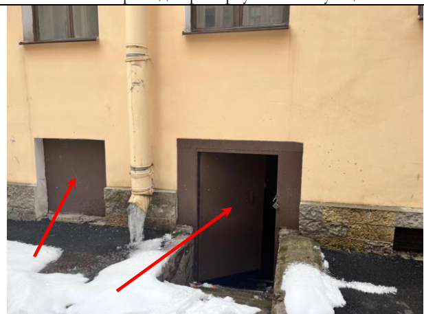
Фото 16. Входная и оконная группа Объекта оценки
