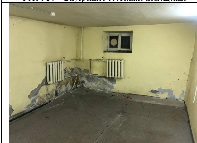
Фото № 11 – Внутреннее состояние помещения
