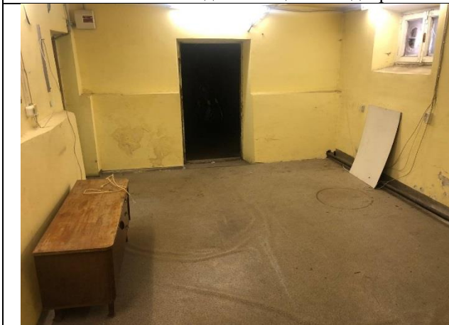
Фото № 9 – Внутреннее состояние помещения
