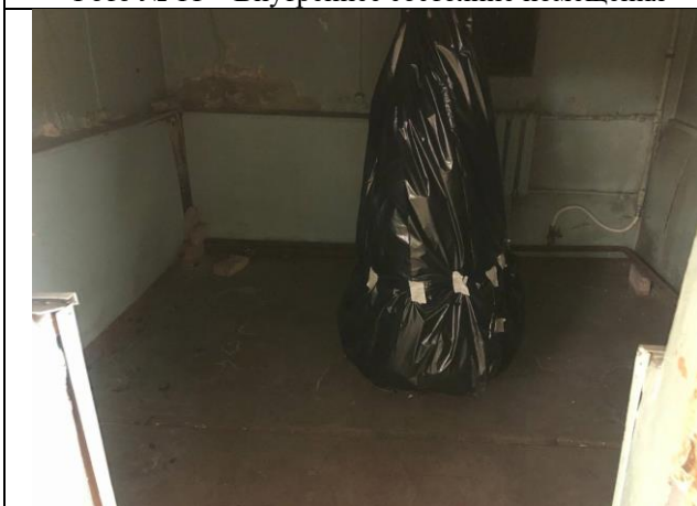
Фото № 13 – Внутреннее состояние помещения
