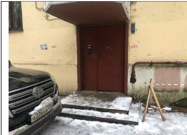
Фото № 7 – Вход в помещение со двора
