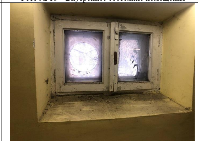
Фото № 12 – Внутреннее состояние помещения
