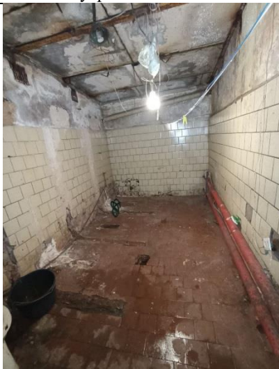
Фото № 15 – Внутреннее состояние помещения
