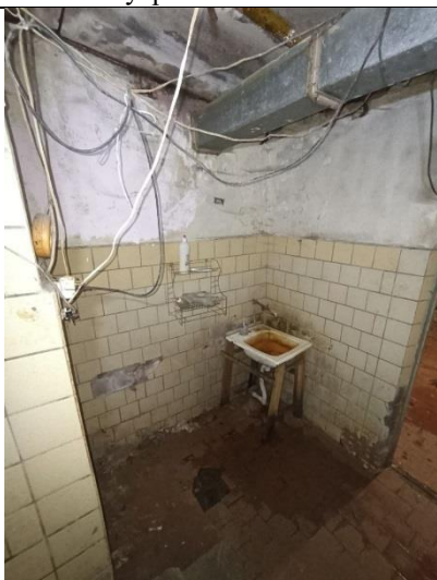
Фото № 13 – Внутреннее состояние помещения
