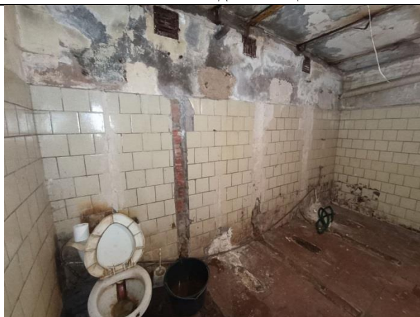
Фото № 7 – Внутреннее состояние помещения
