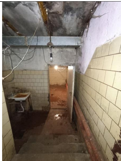
Фото № 12 – Внутреннее состояние помещения
