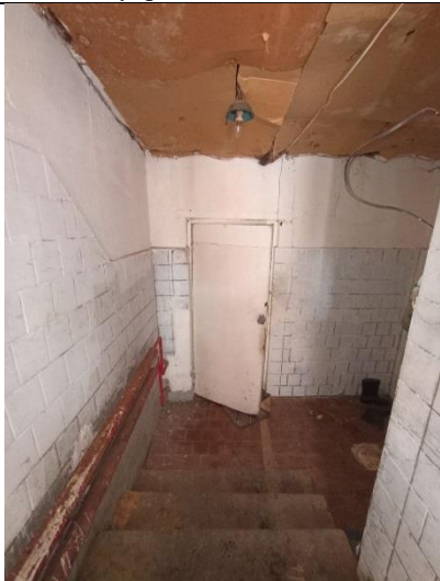
Фото № 9 – Внутреннее состояние помещения
