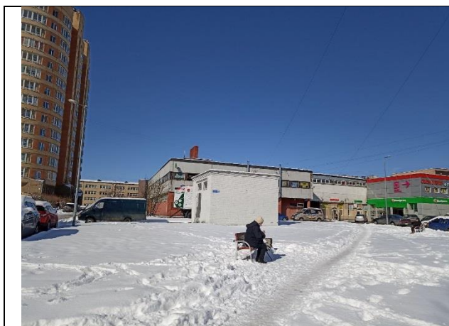
Фото № 1 – Ближайшее окружение и подъездные пути
