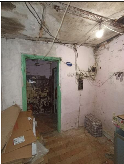
Фото № 11 – Внутреннее состояние помещения
