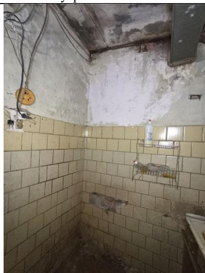
Фото № 14 – Внутреннее состояние помещения
