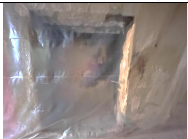
Фото 18. Типичное состояние Объекта оценки
