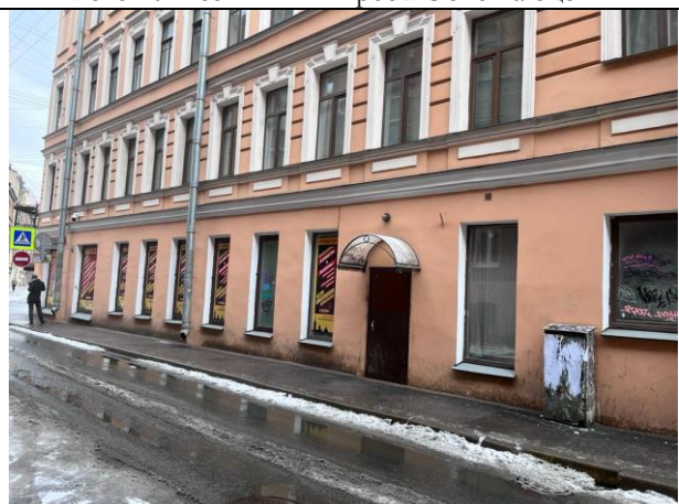
Фото 12. Вид здания расположения Объекта оценки
