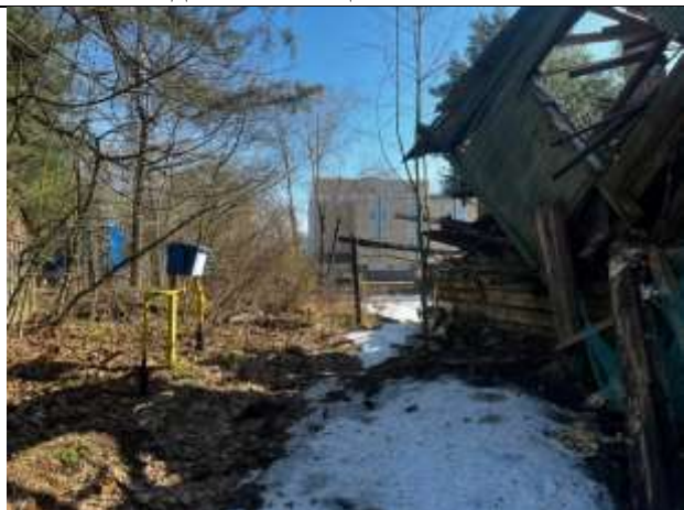
Фото 4. Вид Объекта оценки. Охранная зона газораспределительной сети
