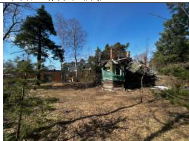
Фото 9. Вид земельного участка Объекта оценки
