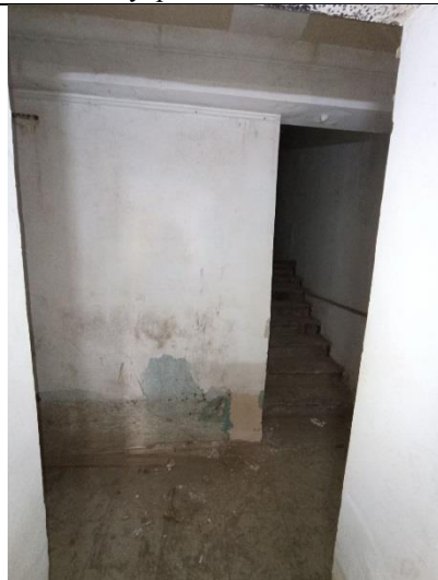
Фото № 14 – Внутреннее состояние помещения
