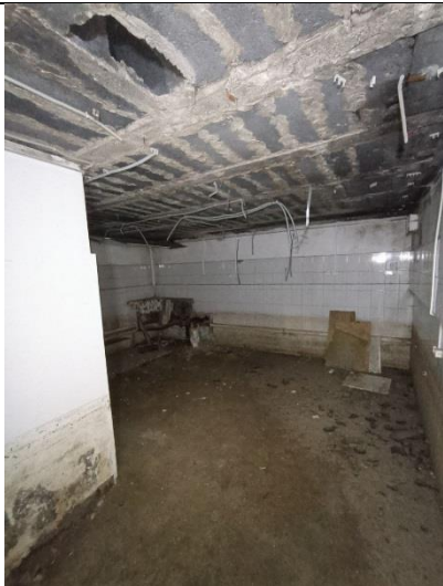
Фото № 9 – Внутреннее состояние помещения
