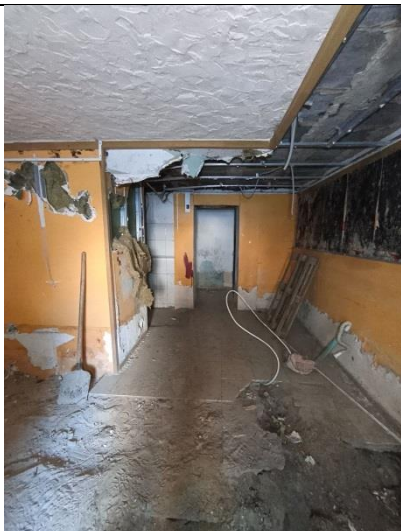
Фото № 11 – Внутреннее состояние помещения
