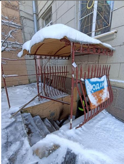
Фото № 5 – Вход в помещение
