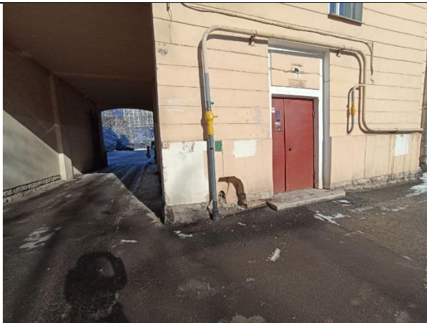
Фото № 7 – Вход в помещение
