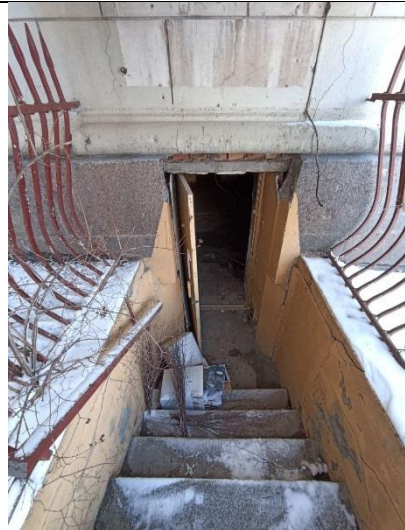
Фото № 6 – Вход в помещение
