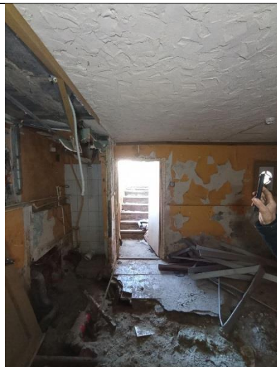
Фото № 12 – Внутреннее состояние помещения
