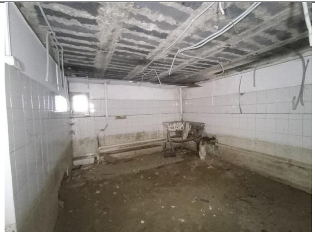
Фото № 8 – Внутреннее состояние помещения
