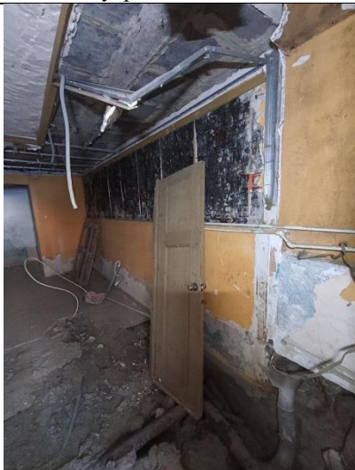
Фото № 13 – Внутреннее состояние помещения
