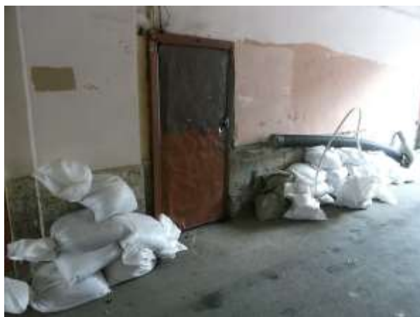
Фото 7. Отдельный вход Объекта оценки
