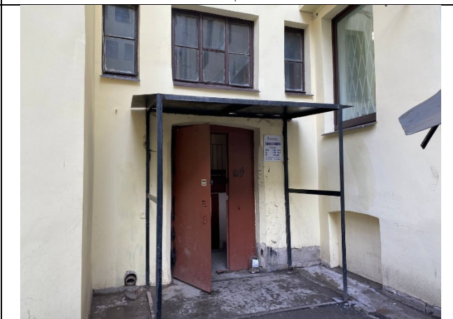
Фото № 4 – Вход в помещение
