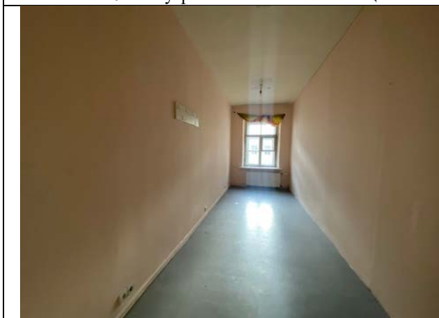
Фото № 11 – Внутреннее состояние помещения
