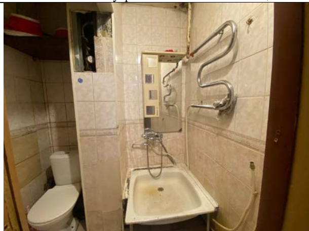
Фото № 16 – Внутреннее состояние помещения
