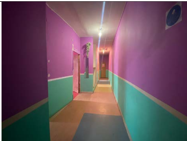
Фото № 13 – Внутреннее состояние помещения
