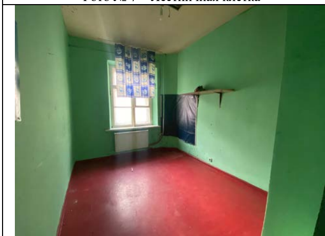
Фото № 9 – Внутреннее состояние помещения
