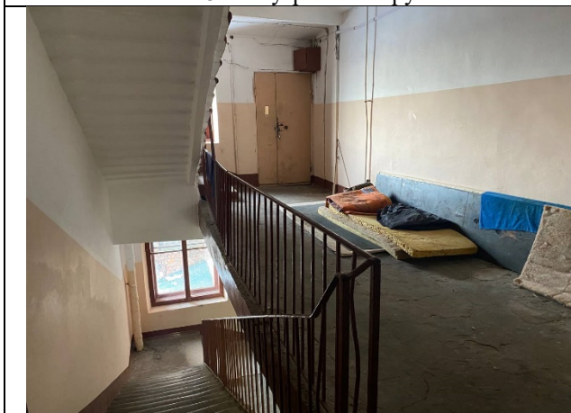
Фото № 7 – Лестничная клетка
