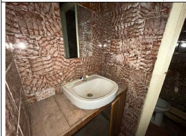
Фото 61. Типичное состояние Объекта оценки
