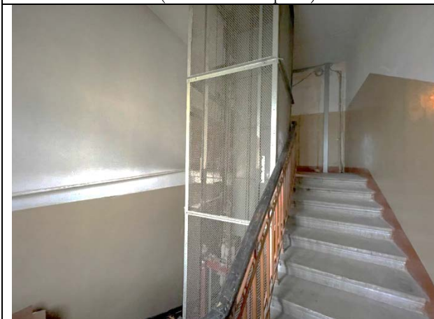
Фото 27. Вид парадной жилого дома (лифт, лестничный проем)
