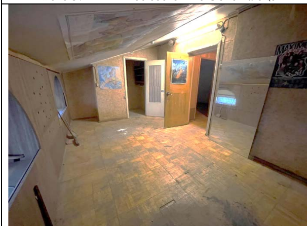
Фото 39. Типичное состояние Объекта оценки
