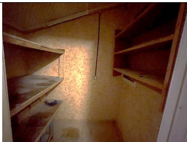
Фото 42. Типичное состояние Объекта оценки
