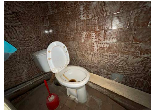
Фото 59. Типичное состояние Объекта оценки
