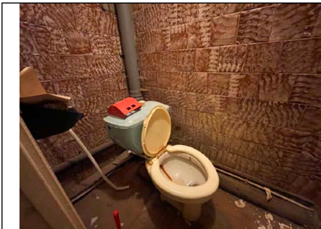
Фото 57. Типичное состояние Объекта оценки
