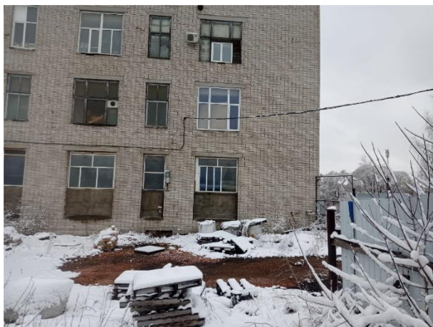
Фото №3 Общий вид объекта оценки
