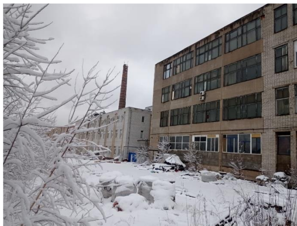
Фото №4 Общий вид объекта оценки
