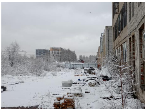
Фото №1 Общий вид объекта оценки
