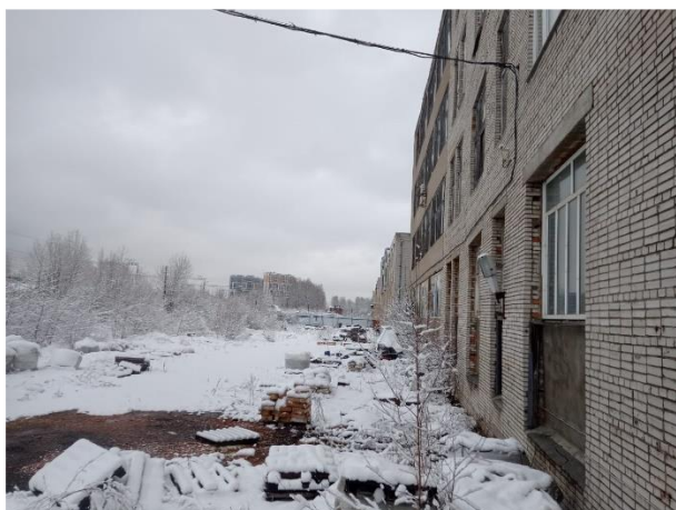
Фото №5 Общий вид объекта оценки
