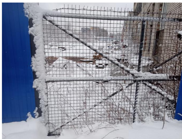
Фото №6 Общий вид объекта оценки
