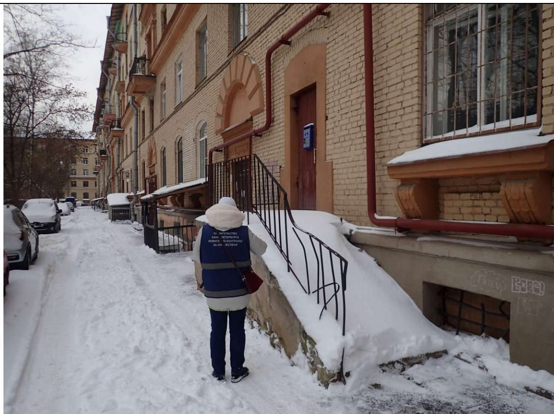
Описание: Вид на вход на Объект
