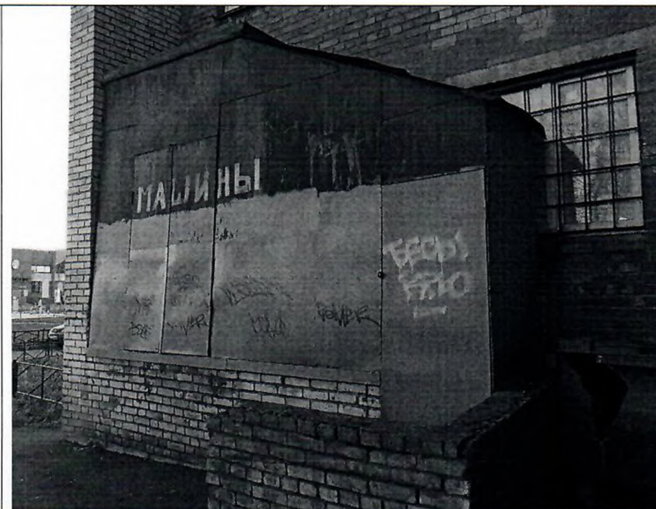
Описание: Вид на Объект
