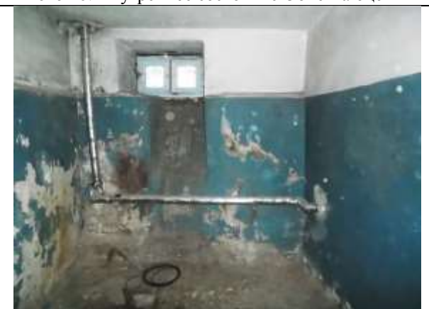
Фото 12. Внутреннее состояние Объекта оценки
