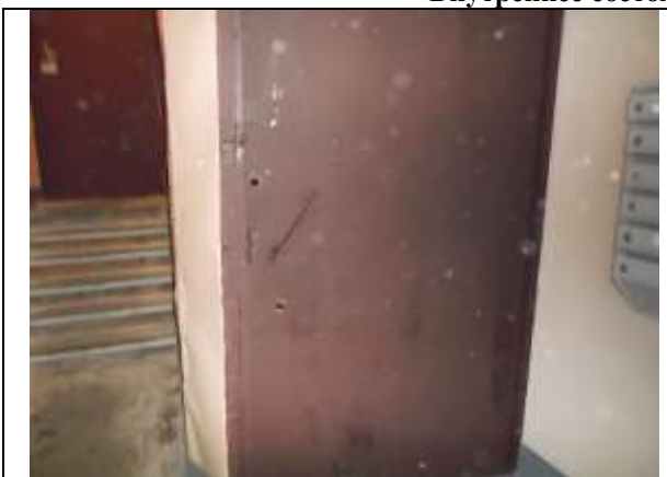
Фото 9. Внутреннее состояние Объекта оценки
