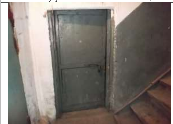
Фото 11. Внутреннее состояние Объекта оценки
