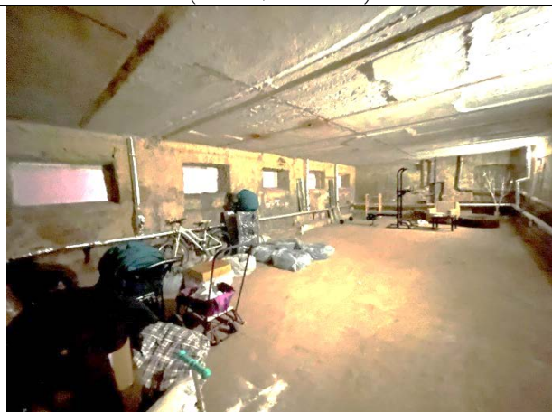
Фото 29. Типичное состояние Объекта оценки (помещение 11-Н)
