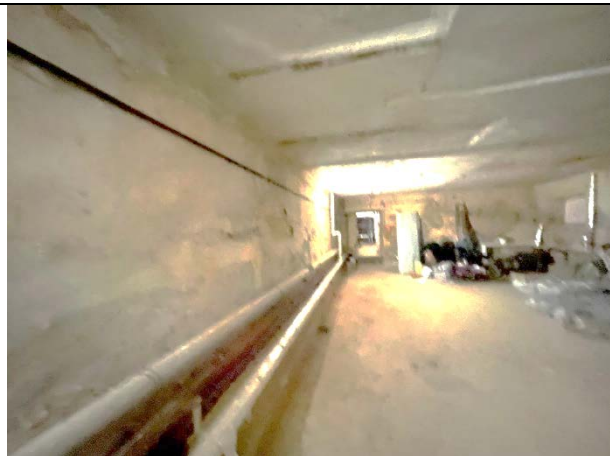
Фото 28. Типичное состояние Объекта оценки (помещение 11-Н)
