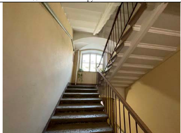
Фото 22. Лестничный проём Объекта оценки
