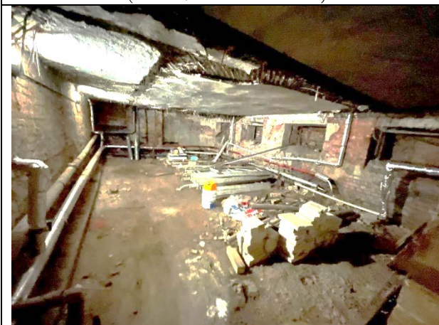
Фото 25. Типичное состояние Объекта оценки (помещение 12-Н)
