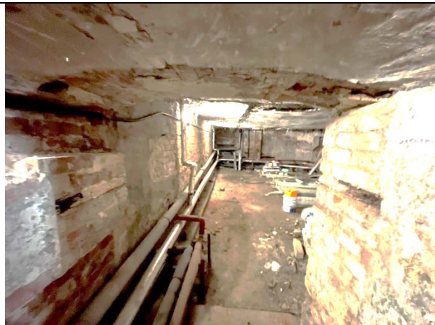
Фото 27. Типичное состояние Объекта оценки (помещение 12-Н)
