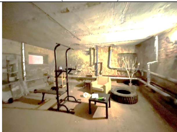
Фото 30. Типичное состояние Объекта оценки (помещение 11-Н)
