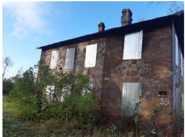
Фото 10. Вид на здание размещения Объекта оценки.
