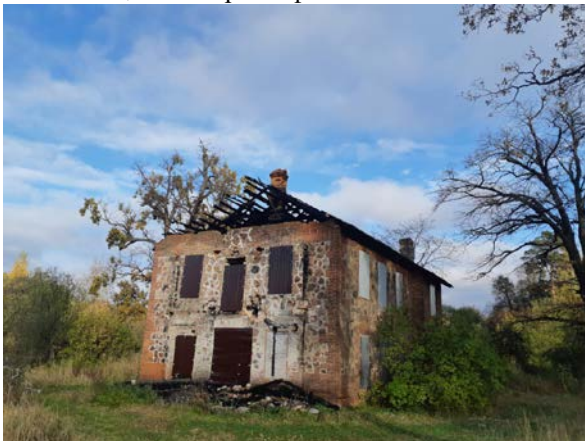
Фото 3. Вид на здание размещения Объекта оценки.
