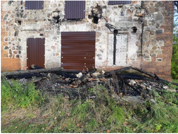
Фото 7. Состояние Объекта оценки.
