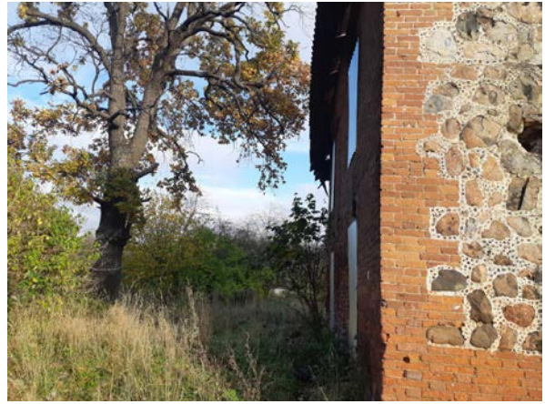
Фото 8. Состояние Объекта оценки.
