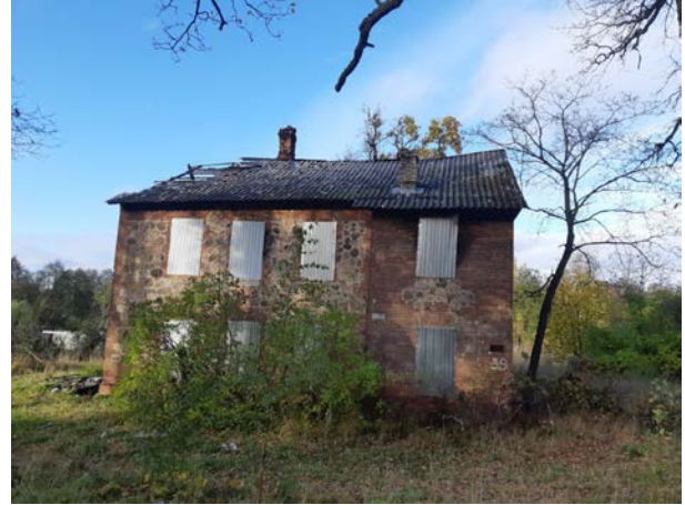
Фото 2. Вид на здание размещения Объекта оценки.
