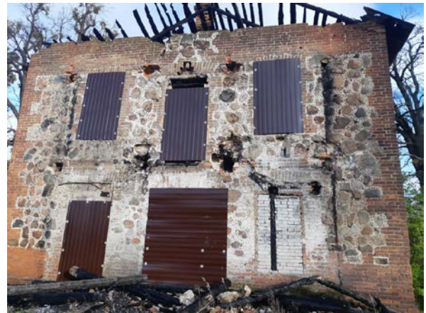
Фото 4. Вид на здание размещения Объекта оценки.
