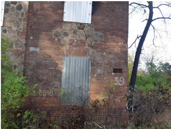
Фото 9. Состояние Объекта оценки.
