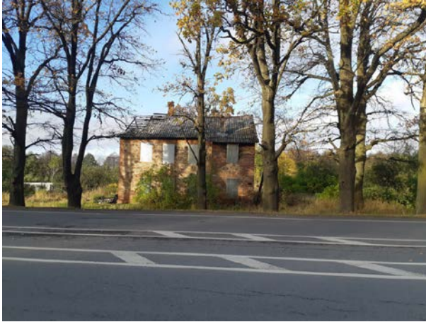
Фото 1. Вид на здание размещения Объекта оценки с Краснофлотского шоссе.
