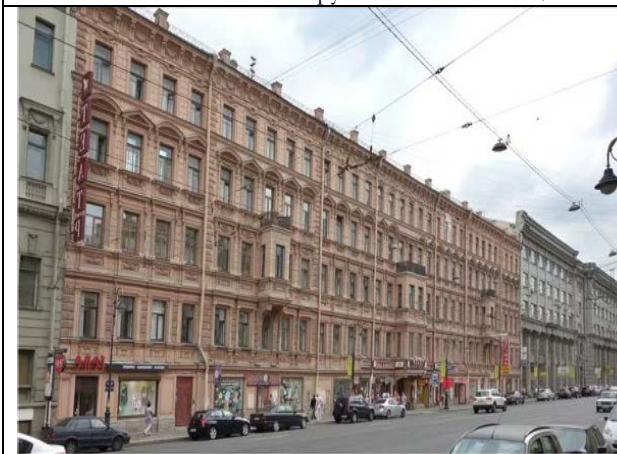
Фото 19. Вид здания расположения Объекта оценки
