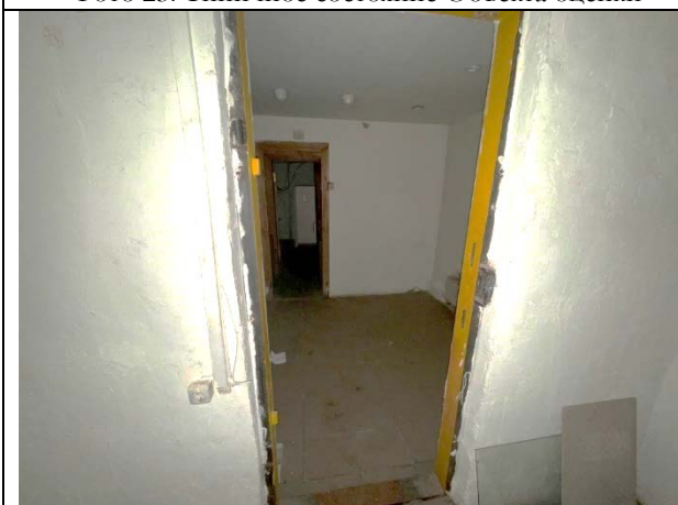
Фото 25. Типичное состояние Объекта оценки
