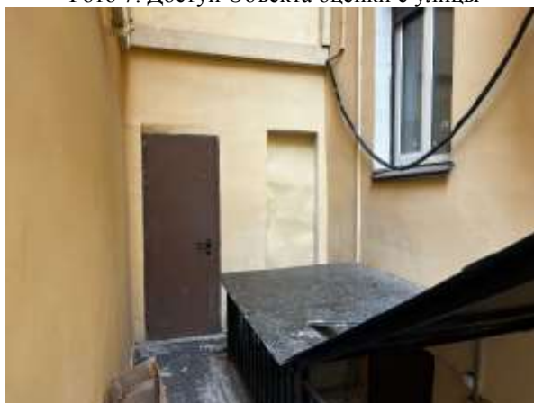
Фото 9. Отдельный вход со двора, окно Объекта оценки
