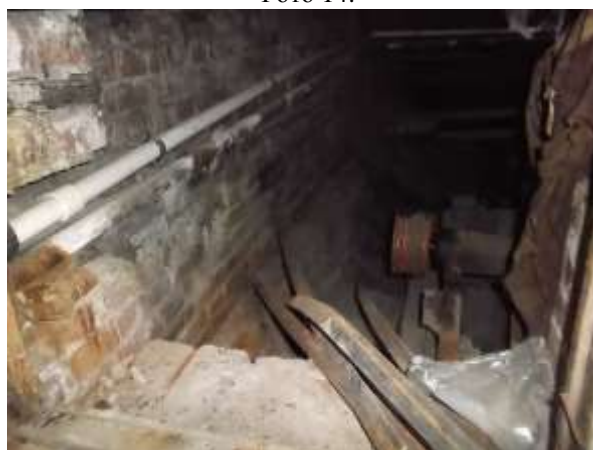
Фото 16. Лаз в стене между ч.п.1 пом.35-Н и ч.п.б/н подвального помещения
