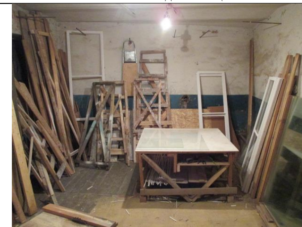
Фото № 8 – Внутреннее состояние помещения
