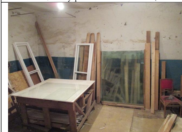
Фото № 11 – Внутреннее состояние помещения
