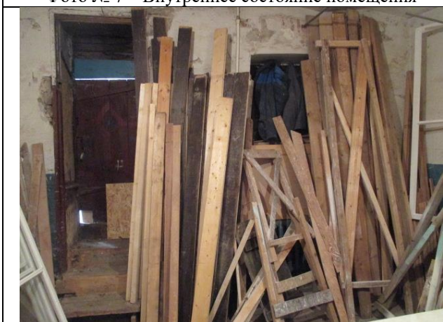
Фото № 9 – Внутреннее состояние помещения
