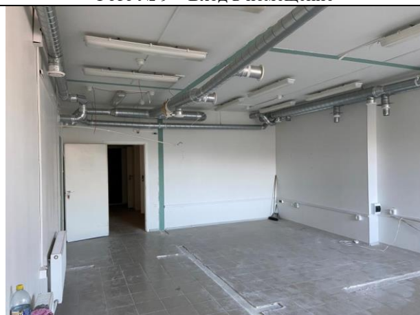
Фото № 11 – Внутреннее состояние помещения
