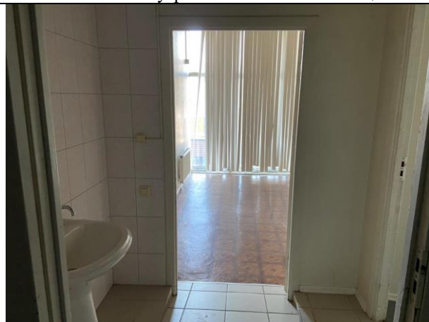
Фото № 19 – Внутреннее состояние помещения
