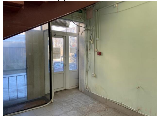
Фото № 26 – Внутреннее состояние помещения
