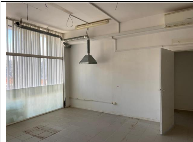
Фото № 23 – Внутреннее состояние помещения
