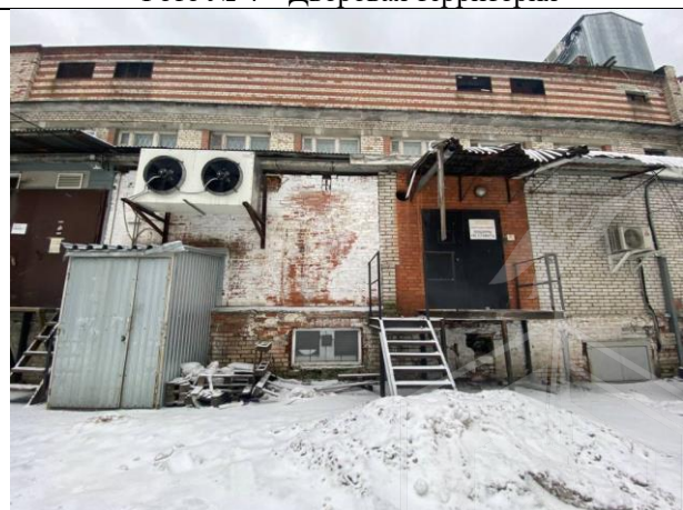
Фото № 6 – Внешний вид здания
