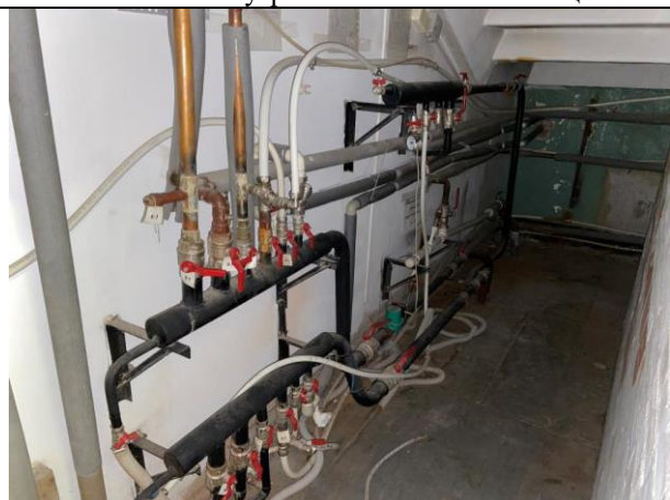
Фото № 13 – Внутреннее состояние помещения
