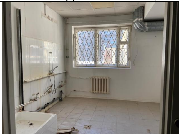
Фото № 21 – Внутреннее состояние помещения
