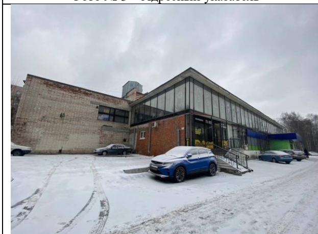
Фото № 5 – Внешний вид здания
