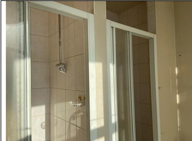
Фото № 15 – Внутреннее состояние помещения
