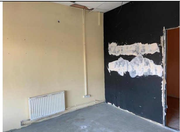
Фото № 10 – Внутреннее состояние помещения
