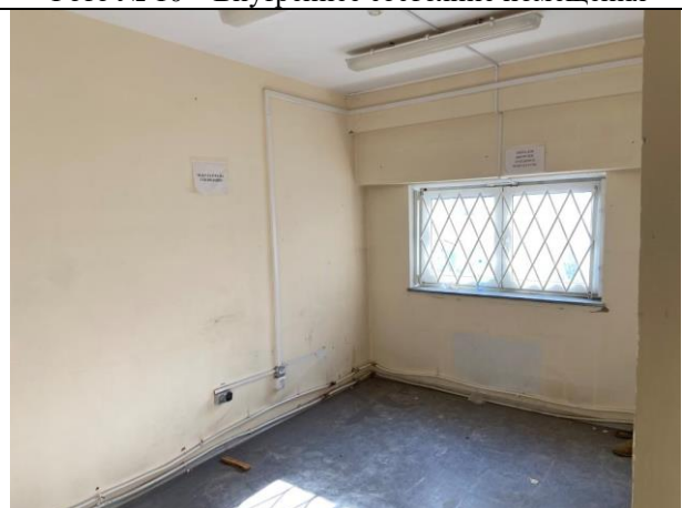
Фото № 12 – Внутреннее состояние помещения
