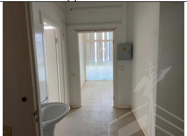
Фото № 22 – Внутреннее состояние помещения
