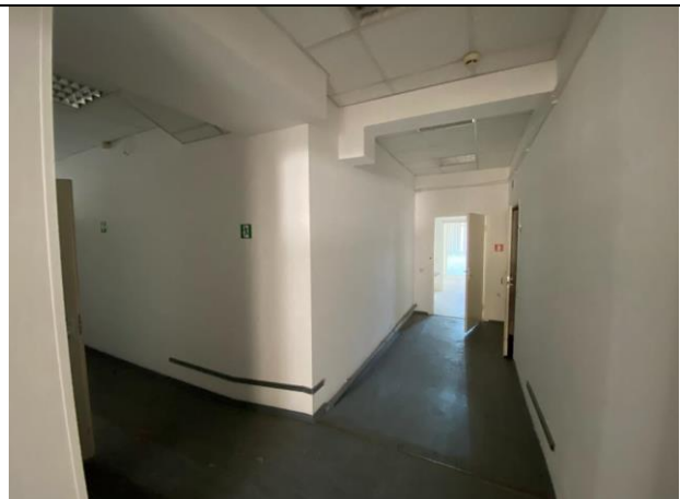
Фото № 24 – Внутреннее состояние помещения
