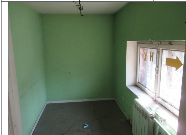
Фото № 11 – Внутреннее состояние помещения
