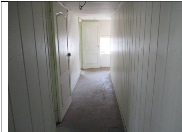
Фото № 9 – Внутреннее состояние помещения
