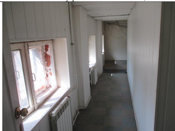
Фото № 12 – Внутреннее состояние помещения
