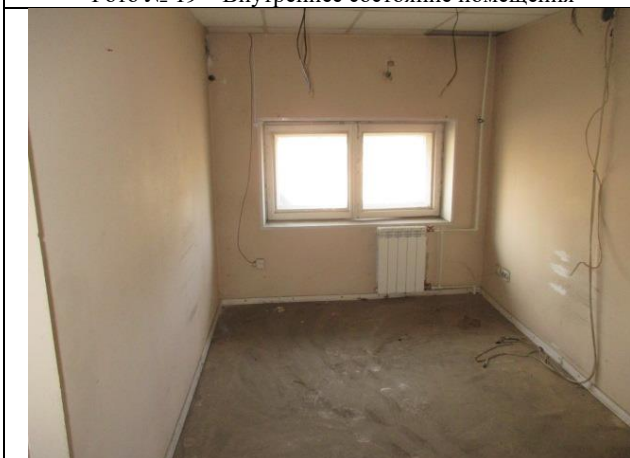
Фото № 21 – Внутреннее состояние помещения
