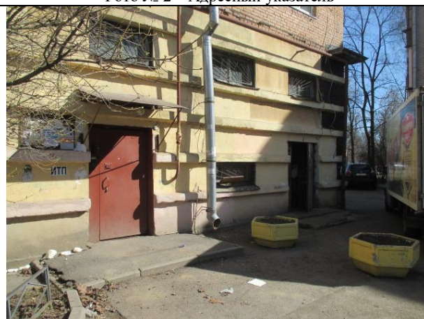
Фото № 4 – Вход в помещение
