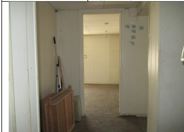
Фото № 7 – Внутреннее состояние помещения
