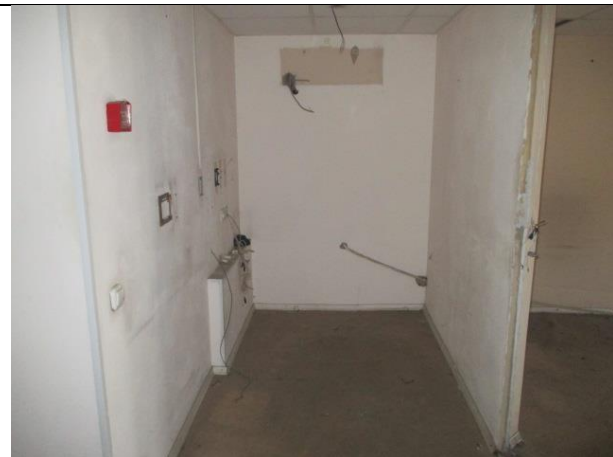
Фото № 18 – Внутреннее состояние помещения
