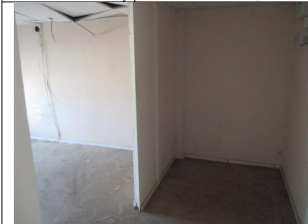
Фото № 19 – Внутреннее состояние помещения
