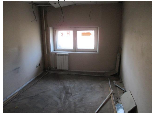
Фото № 20 – Внутреннее состояние помещения
