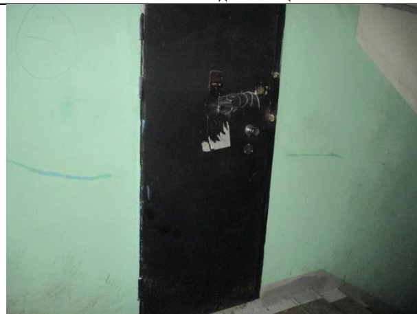
Фото № 6 – Вход в помещение
