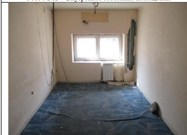
Фото № 15 – Внутреннее состояние помещения
