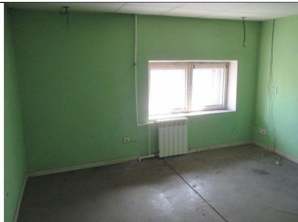
Фото № 10 – Внутреннее состояние помещения
