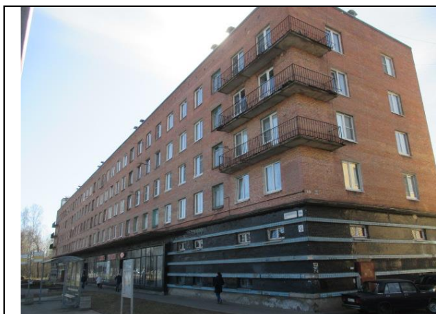
Фото № 1 – Здание, в котором находится Объект оценки
