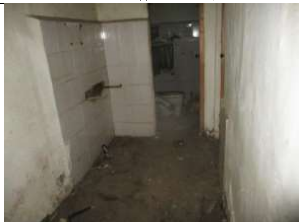
Фото 14. Внутреннее состояние Объекта оценки
