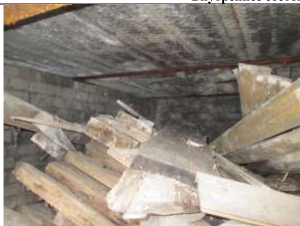
Фото 7. Внутреннее состояние Объекта оценки
