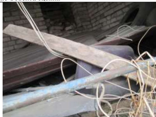
Фото 8. Внутреннее состояние Объекта оценки
