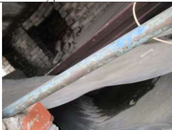
Фото 9. Внутреннее состояние Объекта оценки
