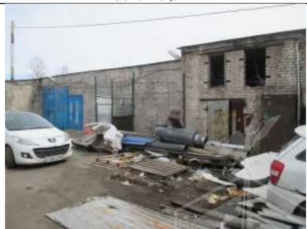
Фото 4. Вид здания, в котором расположен Объект оценки
