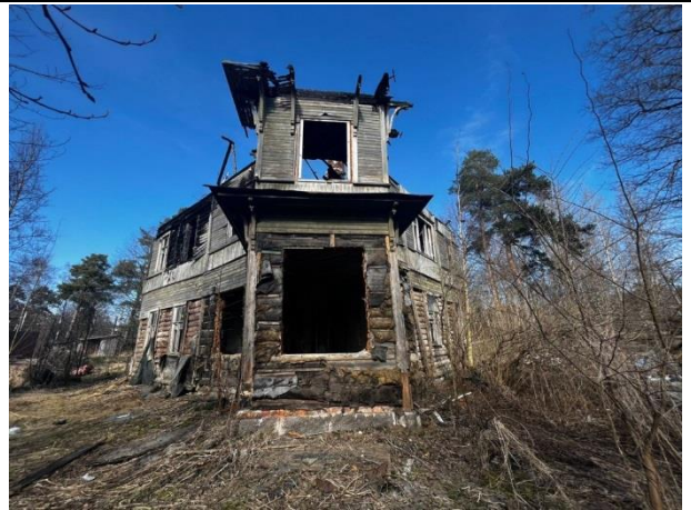
Фото № 6. Внешний вид здания
