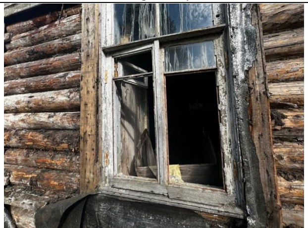
Фото № 10. Внешний вид здания
