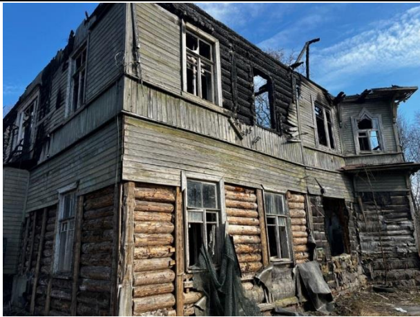
Фото № 7. Внешний вид здания
