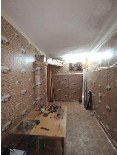
Фото № 9 – Внутреннее состояние
