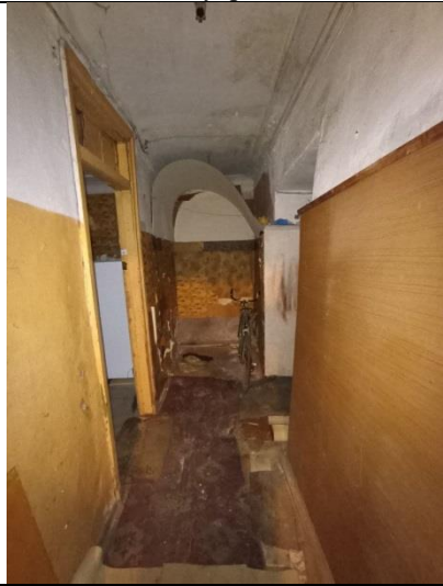
Фото № 16 – Внутреннее состояние
