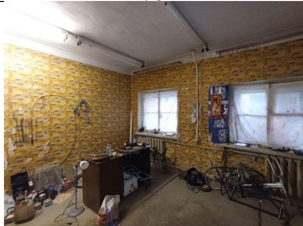
Фото № 17 – Внутреннее состояние
