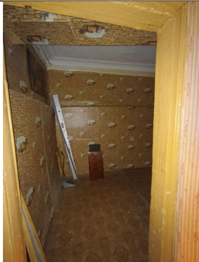
Фото № 14 – Внутреннее состояние
