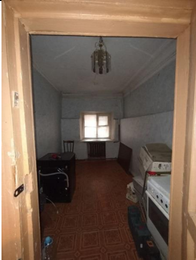
Фото № 11 – Внутреннее состояние
