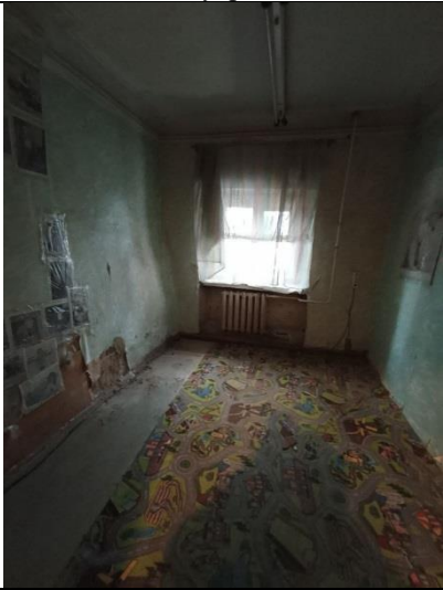
Фото № 15 – Внутреннее состояние
