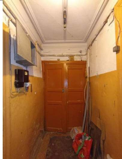
Фото № 22 – Внутреннее состояние
