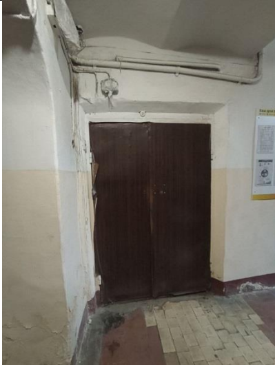
Фото № 7 – Вход в помещение
