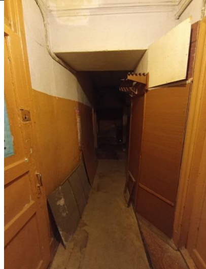
Фото № 8 – Внутреннее состояние
