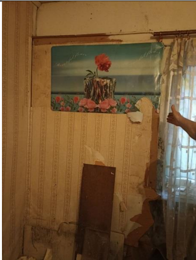
Фото № 13 – Внутреннее состояние
