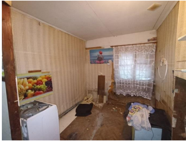
Фото № 19 – Внутреннее состояние
