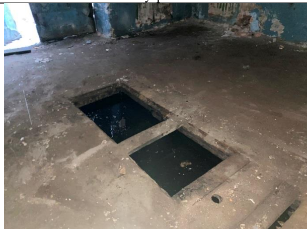
Фото № 9 – Внутреннее состояние
