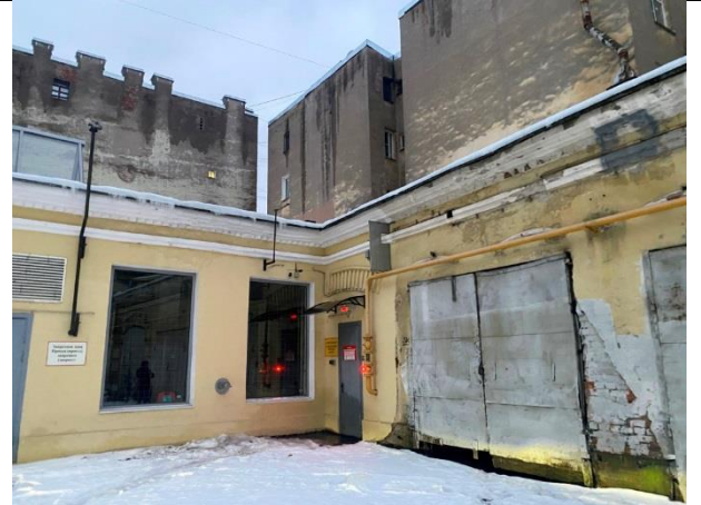
Фото № 4 – Вход помещения
