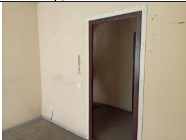
Фото 14. Внутреннее состояние Объекта оценки
