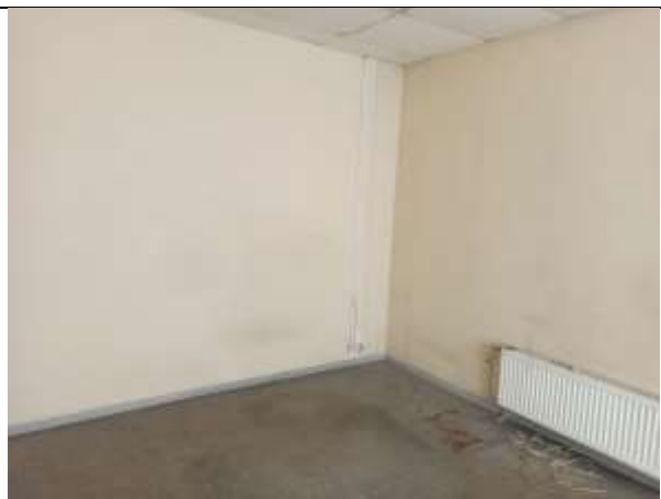
Фото 18. Внутреннее состояние Объекта оценки
