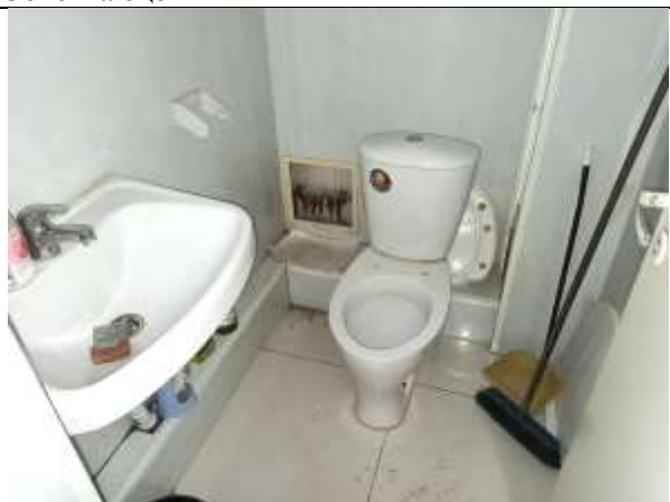
Фото 22. Внутреннее состояние Объекта оценки
