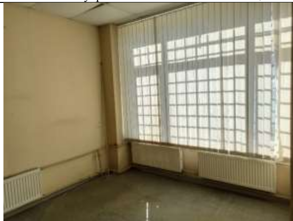
Фото 16. Внутреннее состояние Объекта оценки
