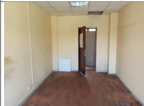
Фото 19. Внутреннее состояние Объекта оценки
