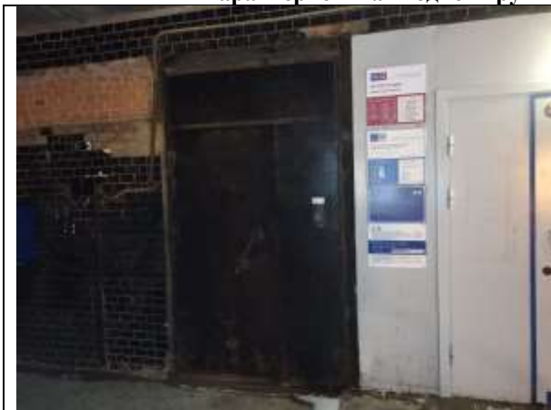
Фото 3. Общий вход Объекта оценки со двора
