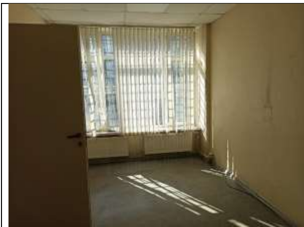
Фото 17. Внутреннее состояние Объекта оценки
