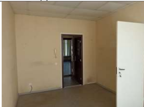
Фото 13. Внутреннее состояние Объекта оценки
