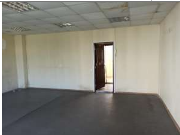
Фото 11. Внутреннее состояние Объекта оценки
