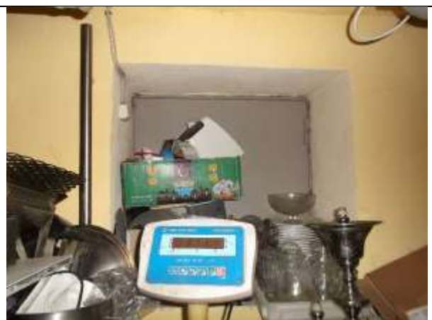
Фото 16. Внутреннее состояние Объекта оценки
