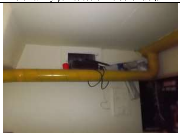
Фото 18. Внутреннее состояние Объекта оценки
