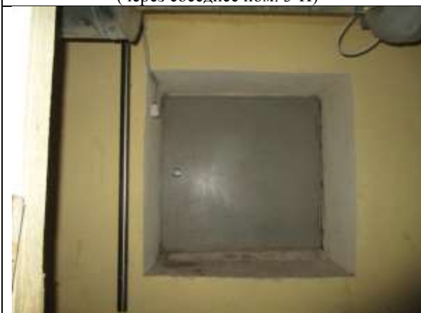
Фото 9. Доступ к Объекту оценки из арки (вид из пом. 7-Н)
