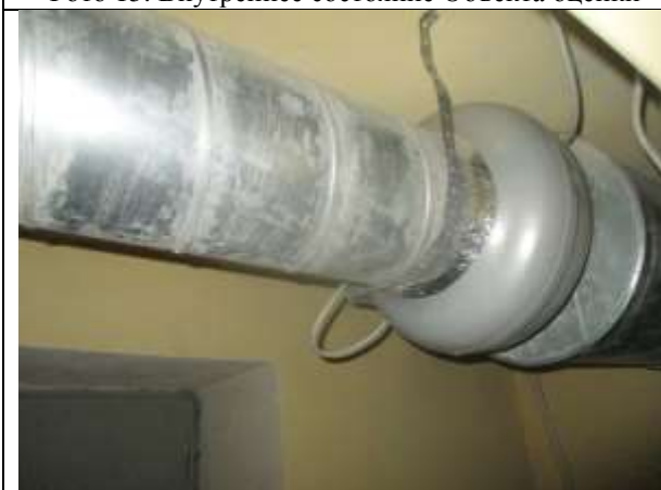
Фото 17. Внутреннее состояние Объекта оценки
