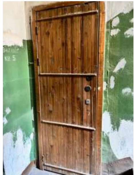
Фото 8. Вход 2 Объекта оценки
