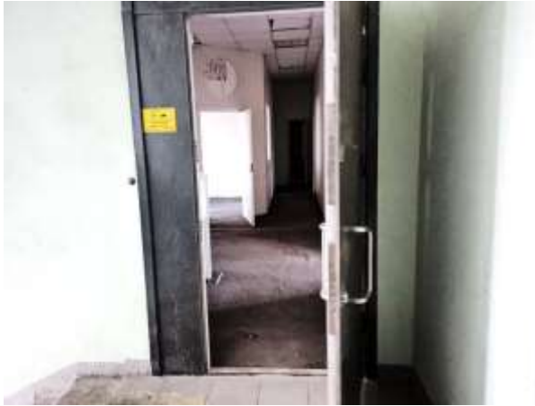
Фото 7. Вход 1 Объекта оценки
