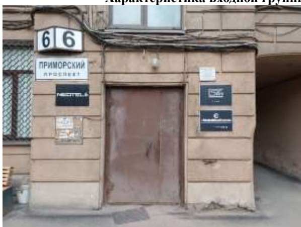
Фото 5. Общий вход 1 с улицы
