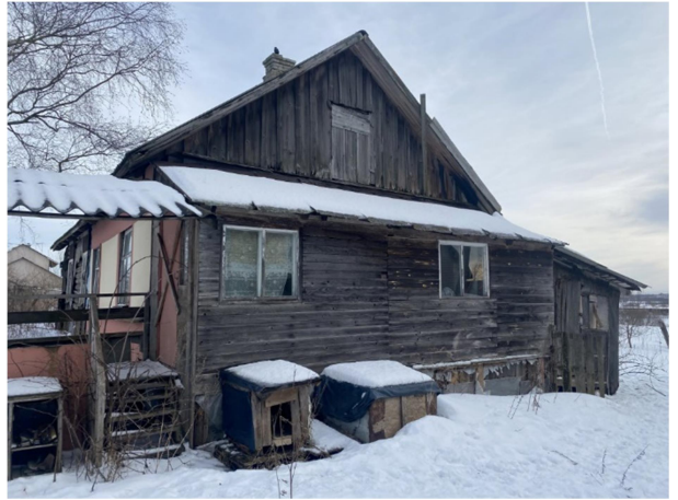
Фото 2. Вид на здание размещения Объекта оценки.
