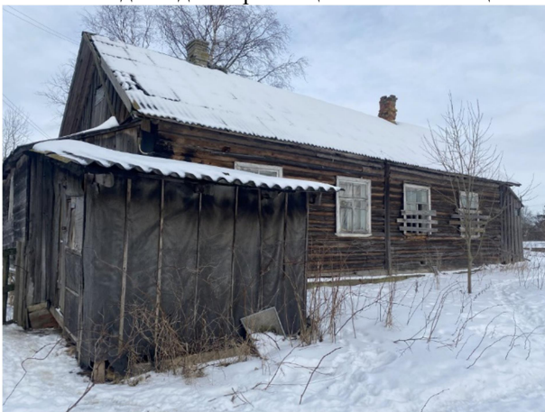
Фото 3. Вид на здание размещения Объекта оценки.
