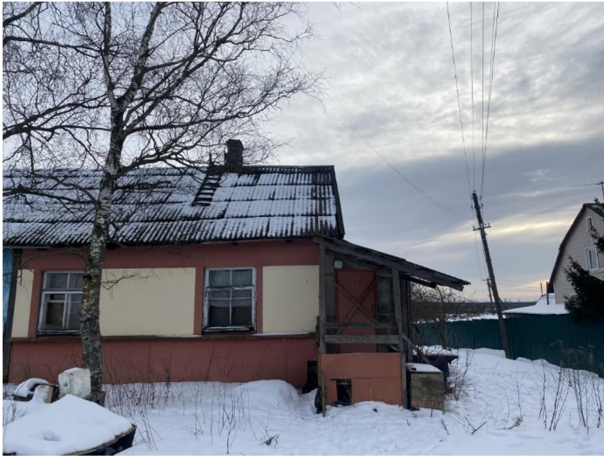
Фото 1. Вид на здание размещения Объекта оценки.
