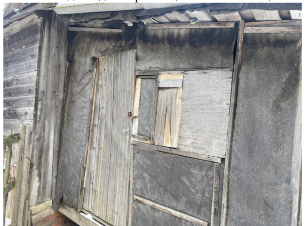
Фото 4. Вид на здание размещения Объекта оценки.
